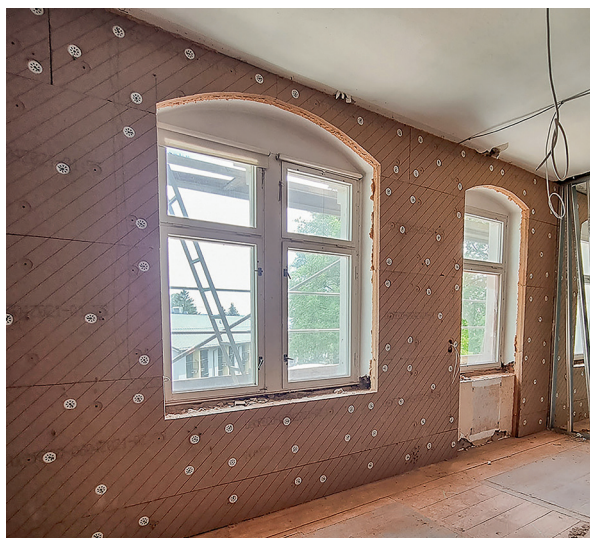
Die Montage erfolgt einfach und trocken. Die mittels Nut und Feder miteinander verbundenen Platten werden mit patentierten, verstellbaren Stelldübeln an der Wand befestigt. Foto: UdiDämmsysteme
