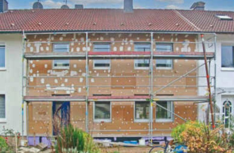
Die Fassadenseiten im Norden und Süden wurden mit einer putzfähigen Holzfaser-Außendämmung versehen.
