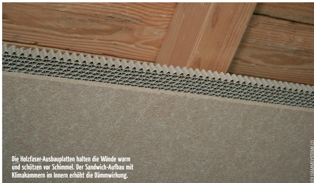
Die Holzfaser-Ausbauplatten halten die Wände warm und schützen vor Schimmel. Der Sandwich-Aufbau mit Klimakammern im Innern erhöht die Dämmwirkung.
