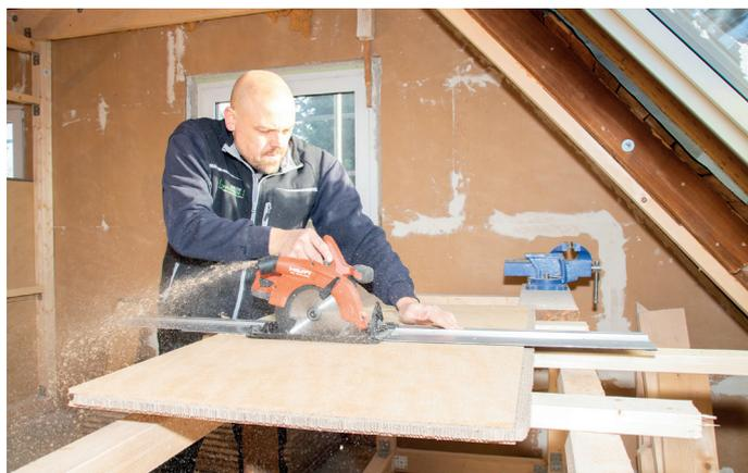
Der Zuschnitt erfolgt per Handkreissäge oder Stichsäge.
