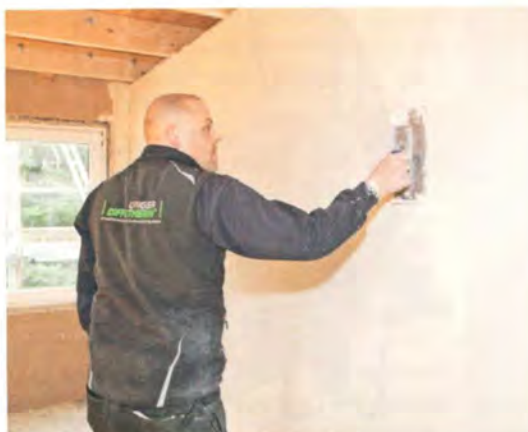
Den Grundspachtel im leicht abgetrockneten Zustand zu einer malerfertigen Oberfläche abschwämmeln
