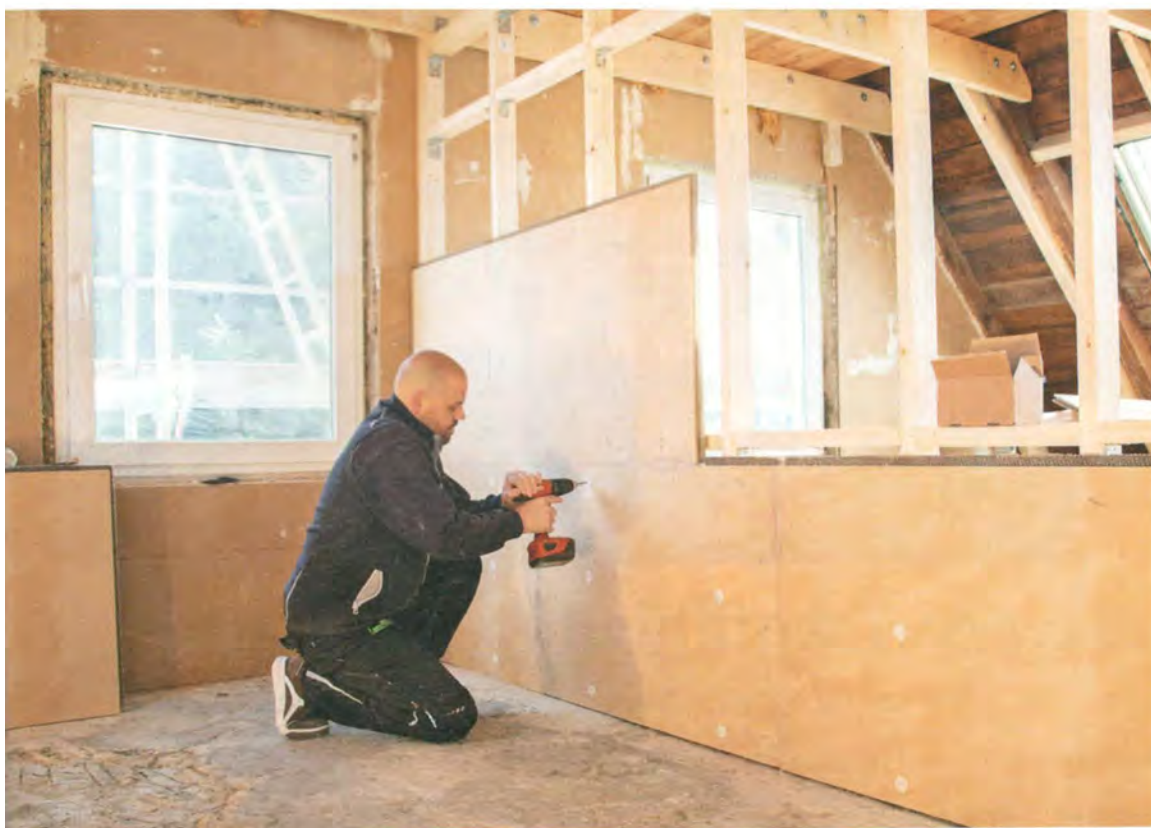
Befestigung der Dämmplatte mit der „Climateschraube“ auf allen tragfähigen Untergründen Fotos: UdiDämmsysteme
