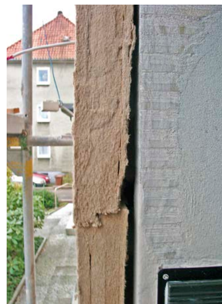
Bild 3 Die Dämmplatten an den Außenseiten wurden in einer Dicke von 10 cm angebracht.
