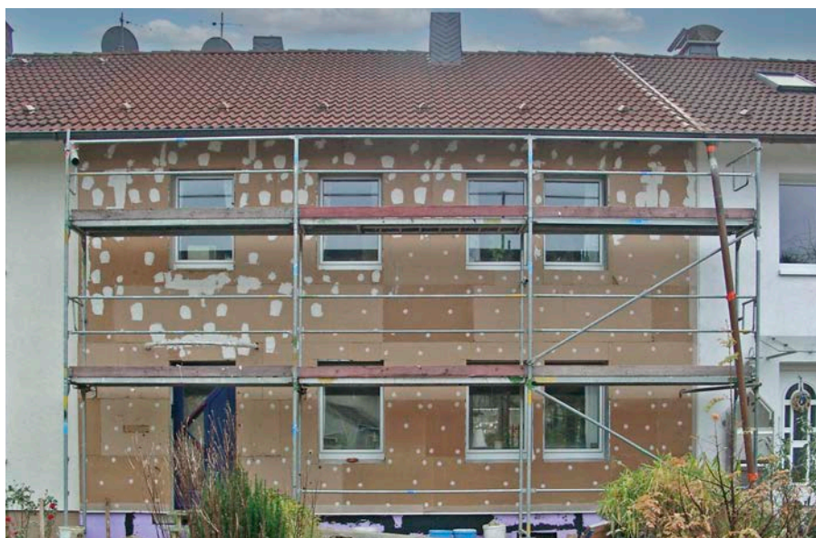
Bild 2 Die Giebelseiten im Norden und Süden wurden mit einer putzfähigen Holzfaser-Außendämmung versehen.
