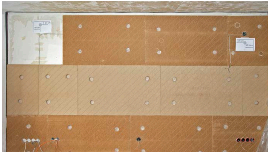
Bild 4 Die an die Nachbarhäuser grenzenden Wände erhielten eine 6 cm dicke Dämmschicht. Da die Holzfasern die Luftfeuchte positiv beeinflussen, hat sich nie wieder Schimmel gebildet.
