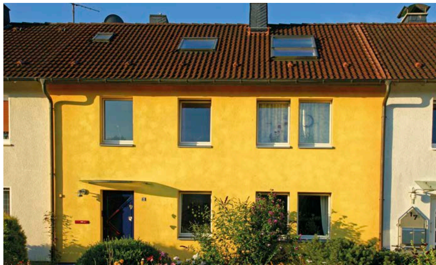
Bild 1 Bei dem Reihenhaus aus den 1950er-Jahren wurden die Heizkosten über einen Zeitraum von 20 Jahren schrittweise um mehr als 70 % gesenkt.
