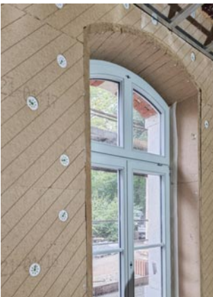
Ein Stelldübel mit integriertem Teller drückt die Matten in die richtige Position und presst die Holzfasern gegen die Wand.
