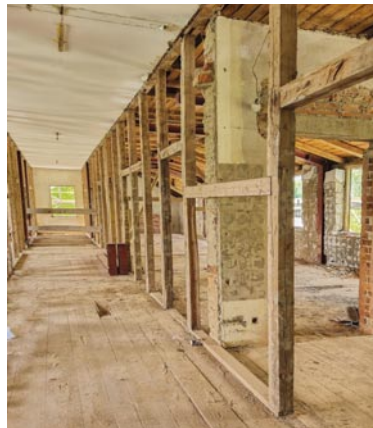
Villa im Schweizer Chalet-Stil: Bei der Sanierung des 1892 erbauten Gebäudes kam aus Denkmalschutzgründen nur eine Innendämmung infrage.
