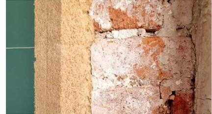
Die biegsamen Dämmplatten schmiegen sich mit ihrer weichen Seite regelrecht an die Mauer an und gleichen so Unebenheiten bis zu 2 cm aus [© UdiDämmssysteme]
