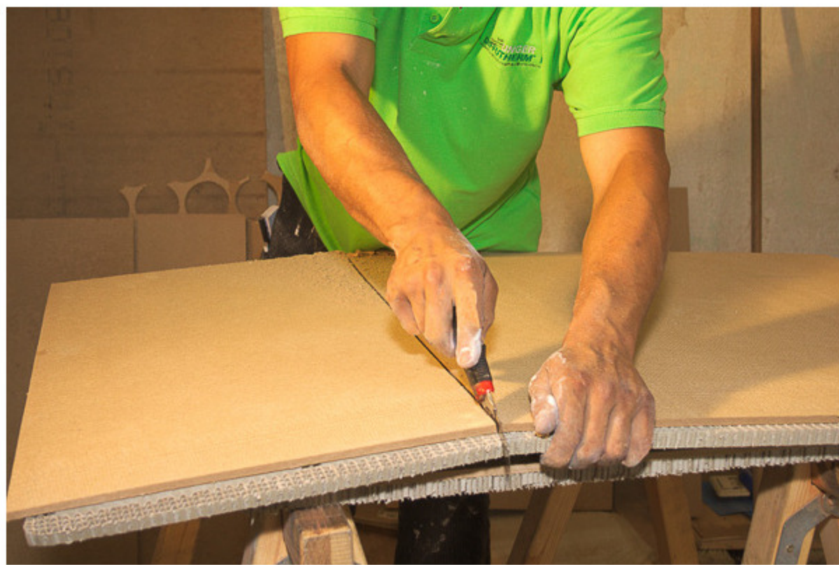
Die Montage ist einfach. Für den Zuschnitt der Dämmplatten genügt in der Regel ein Cuttermesser. Foto: UdiDämmsysteme
