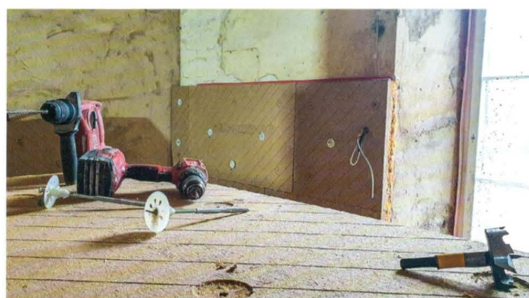
Die Innenseiten der Außenwände wurden mit dem Holzfaser-Dämmsystem „Udi Reco“ gedämmt.
