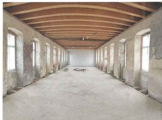
Die Herausforderung bestand v.a. im Dämmen der alten Mauern aus unregelmäßigen Tuff- und Basaltsteinen und im Anarbeiten der Rundungen oberhalb der Fenster [© UdiDÄMMSYSTEME]
