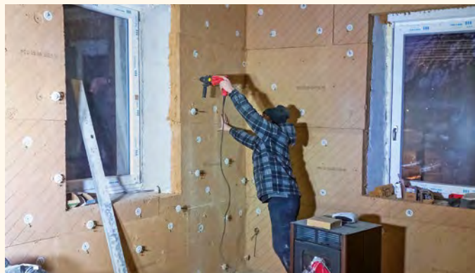
2 | Die Dämmplatten werden mithilfe von patentierten Stelldübeln justiert und fixiert.
