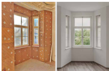
Dank der hohen Rohdichte schützt die Holzfaserinnendämmung effizient vor Wärmeverlust und puffert im Sommer die Hitze [© UdiDämmsysteme]]
