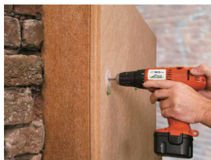
Die flexible Unterseite schmiegt sich an den Untergrund an und gleicht so Unebenheiten von bis zu +/- 20 mm aus [© UdiDämmsysteme]]
