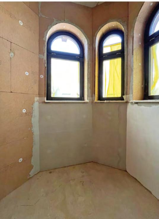
**Einfache Montage ohne Klebstoff und Unterkonstruktion: Patentierte Stelldübel mit integriertem Teller drücken die Platte in die richtige Position.**
