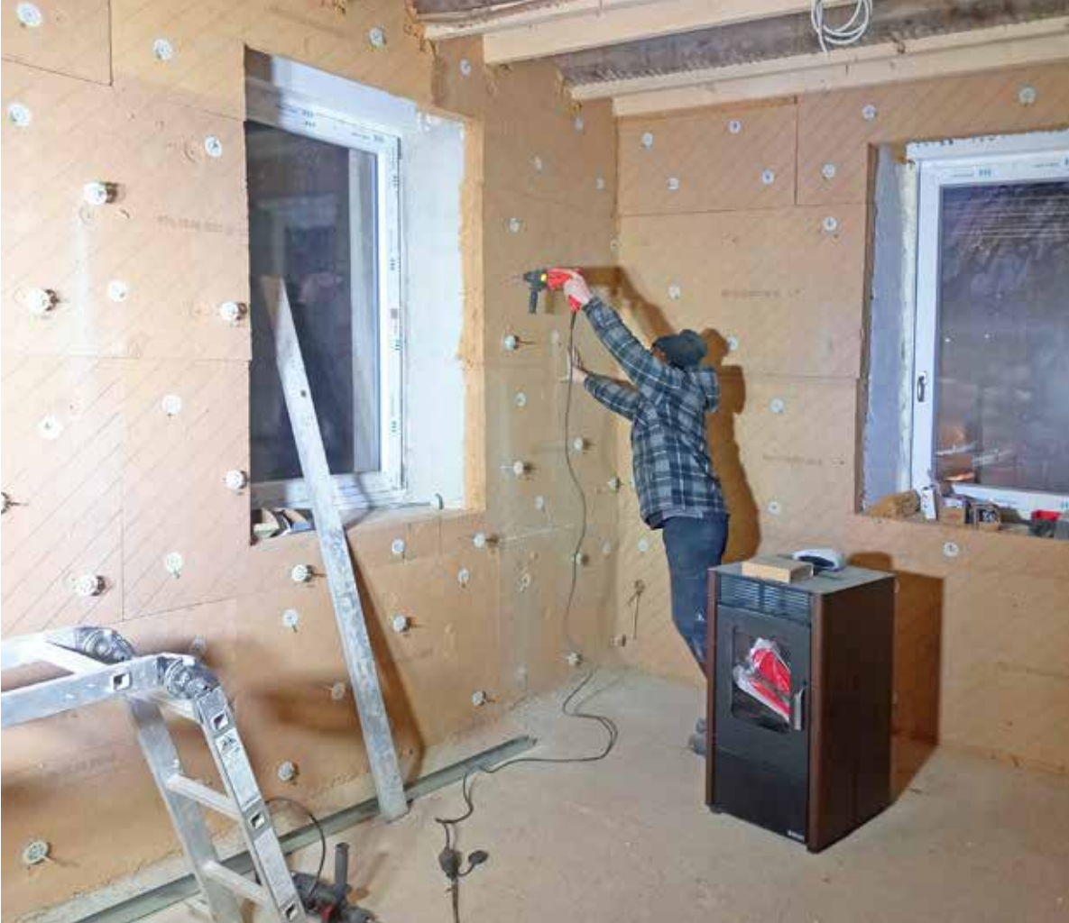
Patentierter Stelldübel mit integriertem Teller drücken die Dämmplatten in die richtige Position
