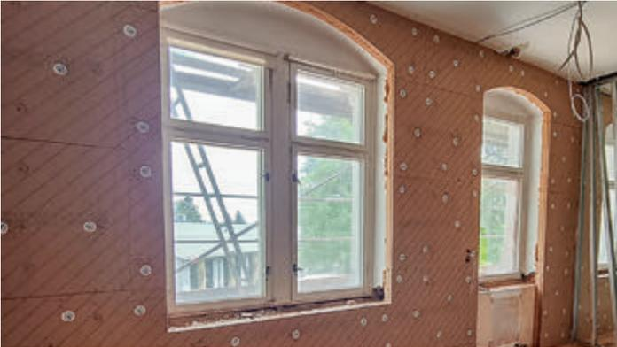
Die mittels Nut und Feder verbundenen Platten werden mit patentierten, verstellbaren Stelldübeln an der Wand befestigt
