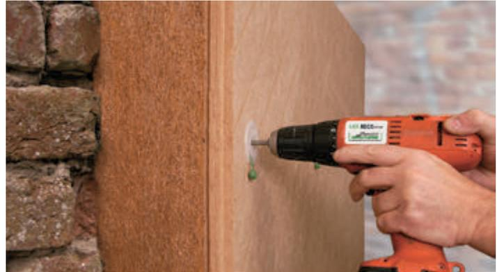
Die flexible Seite schmiegt sich hohlraumfrei an den Untergrund an und gleicht Unebenheiten von +/- 20 mm aus
