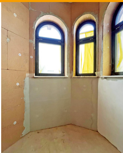
Einfache Montage ohne Klebstoff und Unterkonstruktion: Patentierte Stelldübel mit integriertem Teller drücken die Platte in die richtige Position.
