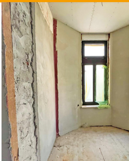
Die harte und glatte Seite der Dämmplatten kann problemlos verputzt werden.
