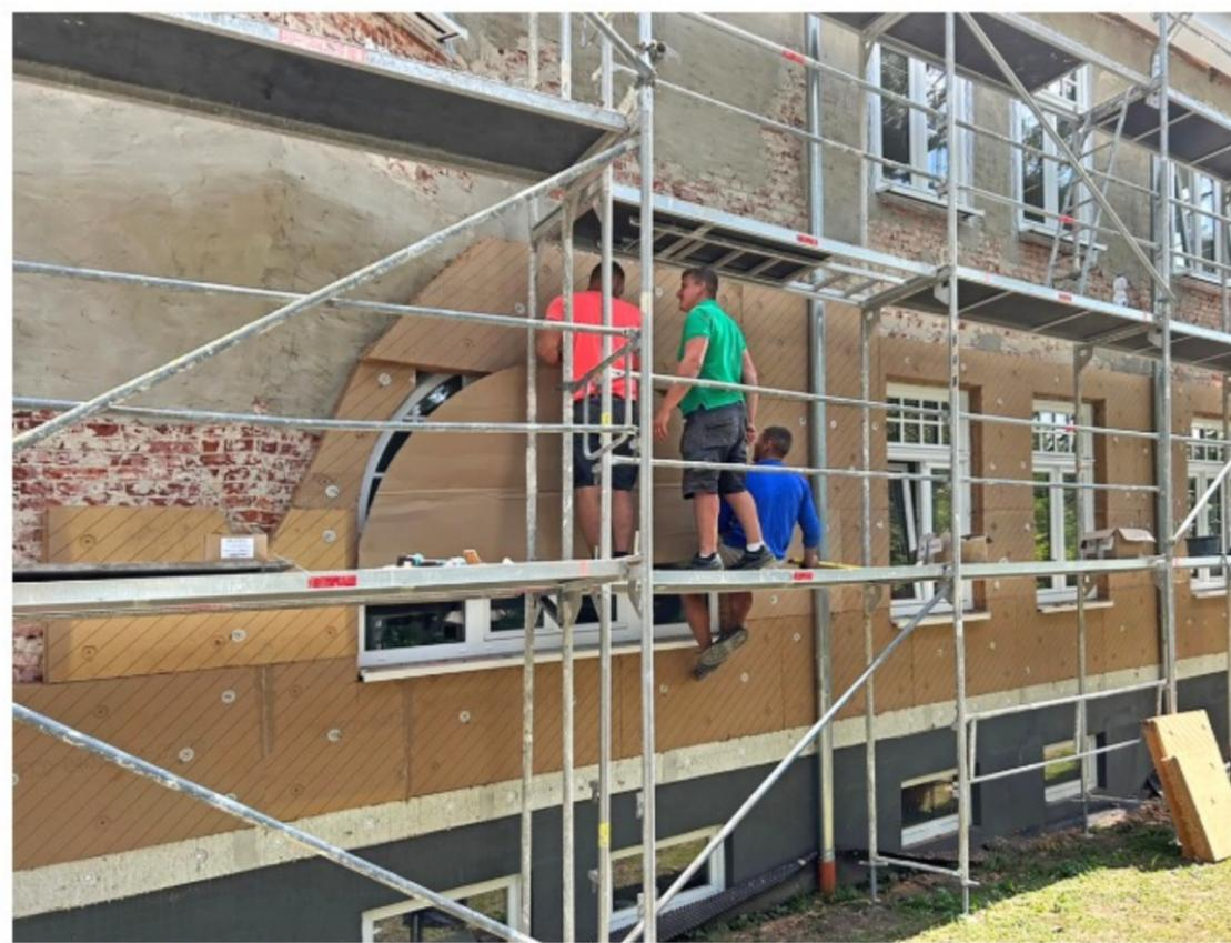
Die komplette Fassade wurde mit 100 mm dicken Holzfaserplatten gedämmt. Patentierte Stelldübel mit integriertem Teller drücken die Dämmplatten in die richtige Position
