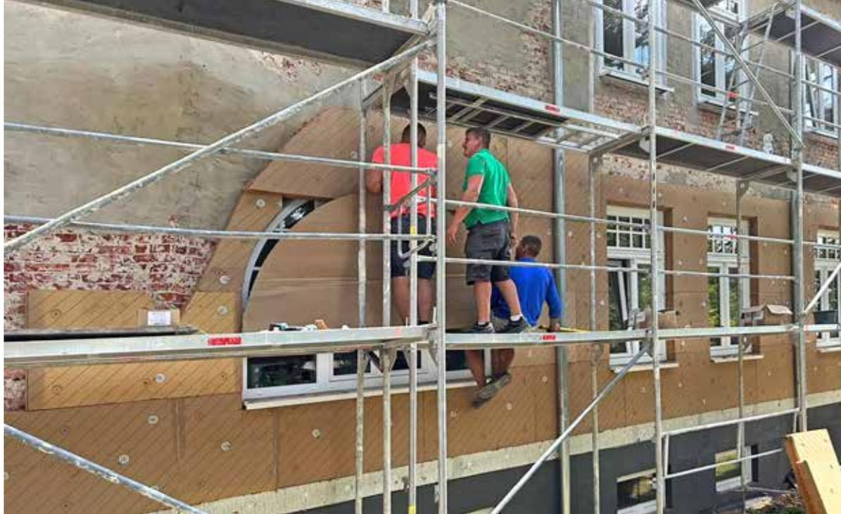
Die komplette Fassade wurde mit 100 mm dicken Holzfaserplatten gedämmt. Patentierte Stelldübel mit integriertem Teller drücken die Dämmplatten in die richtige Position
