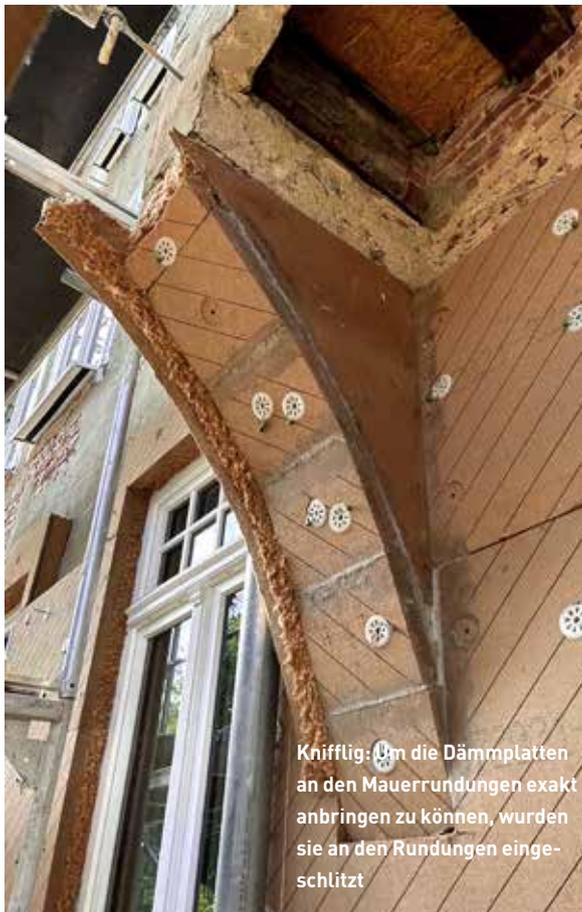
Knifflig: Um die Dämmplatten an den Mauerrundungen exakt anbringen zu können, wurden sie an den Rundungen eingeschlitzt
