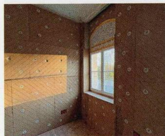
Für das Anbringen der Holzfaser-Dämmplatten UdiIN RECO ist weder eine Unterkonstruktion noch Klebstoff nötig. Stelldübel mit integriertem Teller drücken die Dämmplatten in die richtige Position.
