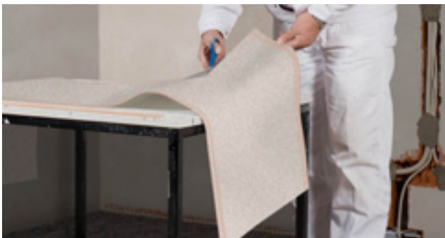
Zuschnitt der Heizbahnen (falls notwendig)
