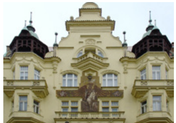
Denkmalpflege zur Erhaltung der Bausubstanz
