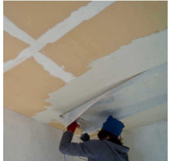
UdiSUN® beim Einspachteln
