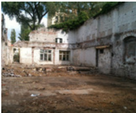
Ruine vor dem Aufbau
