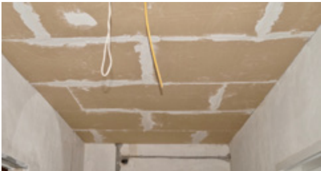
UdiDÄMMUNG montieren
