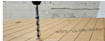
Während der Plattenmontage erfolgt eine Bohrung mittels Spiralbohrer um die Leitung durch die Platte zu führen. Wichtig dabei, die Position der Durchführung sollte leicht versetzt zur zukünftigen Dose platziert sein.
