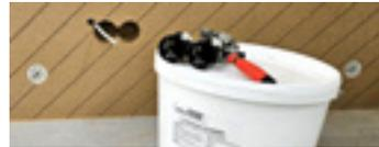
Die Bohrungen werden von Staub befreit um darauf folgend geschlossene Unterputzgerätedosen mittels **UdiSPEZIALKLEBER** einzukleben.
