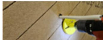
Nachdem alle Platten montiert und ausgerichtet sind werden die notwendigen Öffnungen angezeichnet und mittels Lochkreissäge gebohrt.
