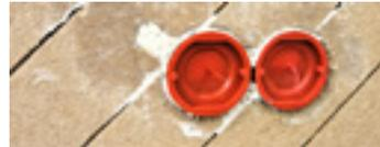
Der Bereich, in dem sich die Zuleitung befunden hat, kann mittels einem Holzfaserkleber-Gemisch verschlossen werden. Für die weiterführenden Spachtelarbeiten sollten Schutzkappen verwendet werden.
