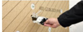
Der Kleber wird sowohl auf die Innenseiten der Bohrungen als auch auf die Unterputzgerätedosen aufgetragen.
