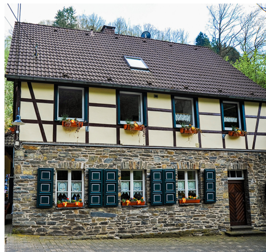
400 Jahre altes Gehöft erfüllt jetzt Niedrigenergiestandards
