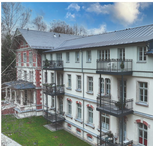
Historische Villa mit Innendämmung UdiIN RECO gedämmt
