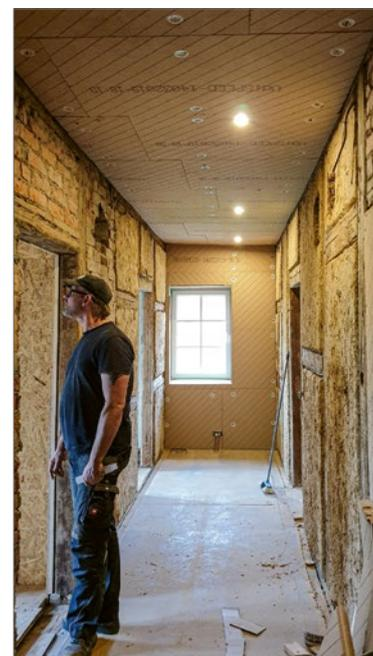
Rechts: Jens Ensfelder dämmte das Fachwerk sowie die Decke unter dem unbeheizten Speicher mit Holzfaser-Dämmplatten. Hier sind auch die Teller der Stelldübel gut zu sehen, die den Dämmstoff andrücken.
