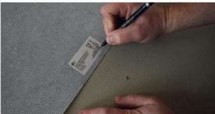
Bei zugeschnittenen Bahnen gemessene Widerstände auf beiliegenden Etiketten eintragen und auf der Heizbahn aufkleben.
