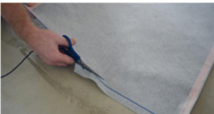
Soll die komplette Bahn ohne individuellen Zuschnitt verarbeitet werden, ist eine Kontaktierung senkrecht entlang der Bahn abzuschneiden.
