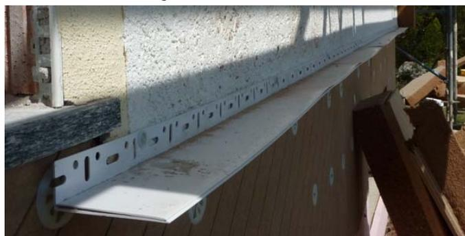
UdiBASE<sup>®</sup> Sockelabschluss Wandanschlussprofil
