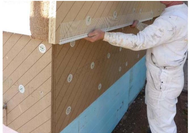
Es entsteht ein sauberer und thermisch einwandfreier Sockelabschluss mit integrierter Tropfnase zum Schutz vor eindringender Feuchtigkeit, durch Regen oder Schnee.
