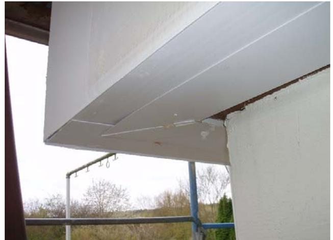
Nun kann die vollflächige Gewebespachtelung mit 10 cm Überlappung des **UdiARMIERUNG<sup>®</sup> Gewebe** und **UdiGRUNDSPACHTEL<sup>®</sup>** mit abschließendem Deckputz, z.B. **UdiPERL<sup>®</sup>** oder **UdiSILANO<sup>®</sup>** etc. aufgebracht werden. Das Armierungsgewebe muss mit dem Gewebestreifen des Aufsteckprofils mindestens 10 cm im Armierungsspachtel überlappen.
