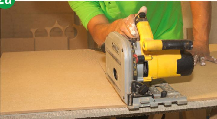
Der Zuschnitt der **UdiIN 2CM<sup>®</sup> Dämmplatten** erfolgt am Besten mit elektrischen Holzbearbeitungsmaschinen, Handkreissäge oder Stichsäge.
