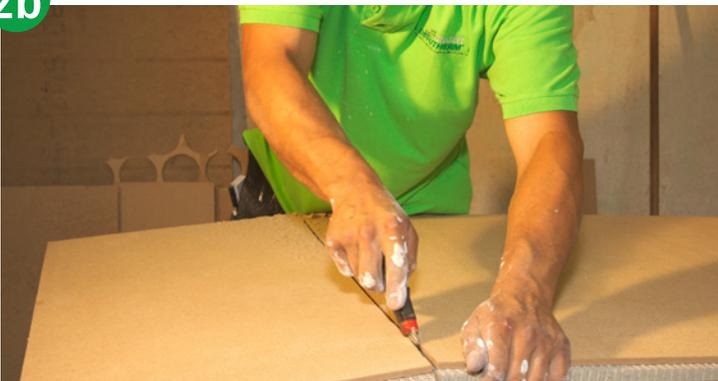
Selbst ein Cuttermesser reicht aus, um die **UdiIN 2CM<sup>®</sup> Dämmplatte** zu teilen.
