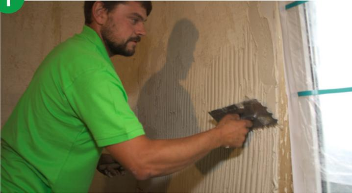
Nachdem Sie den zu dämmenden Untergrund auf Festigkeit überprüft haben, mischen Sie einfach den **UdiGRUNDSPACHTEL<sup>®</sup>** an und ziehen diesen direkt mit einer Zahnkelle (8-12 mm Zahnung) entsprechend den Untergrundgegebenheiten auf.
