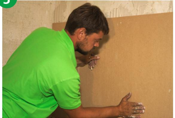
Die Dämmplatten werden mit leichtem und gleichmäßigem Druck in das aufgetragene Spachtelbett aufgelegt. Halten Sie danach eine Antrocknungszeit von rund 2 Tagen ein (bei Normaltemperatur 18°C und 60 % rel. LF).
