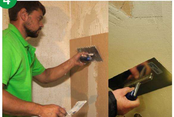
Abschließend wird der **UdiGRUNDSPACHTEL<sup>®</sup>** auf die verlegte Dämmfläche aufgezogen und mit **UdiARMIERUNG<sup>®</sup> Gewebe** für Stabilität überspannt.
