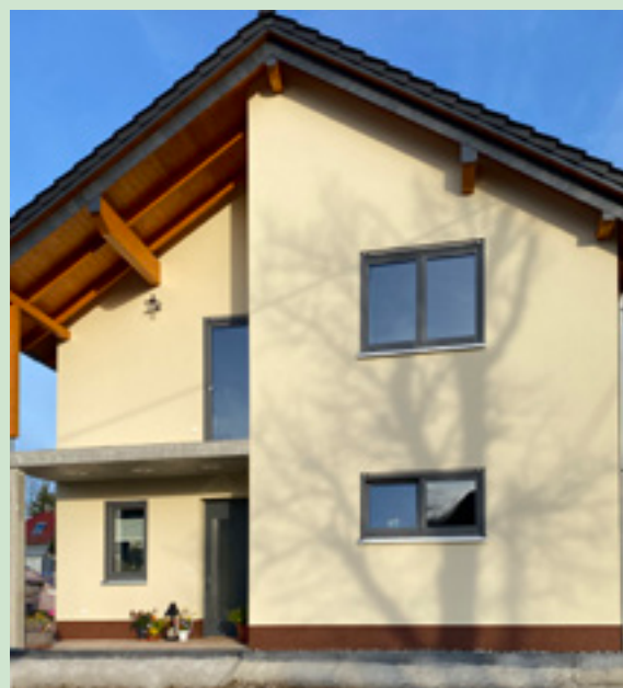
Außenansicht EFH nach Fertigstellung
