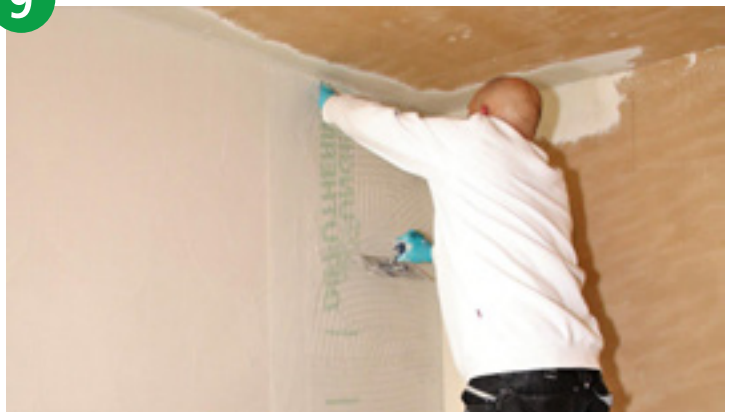
Abschließend wird der UdiGRUNDSPACHTTEL® auf die verlegte Dämmfläche aufgezogen und das UdiARMIERUNG® Gewebe für Stabilität eingebettet.
