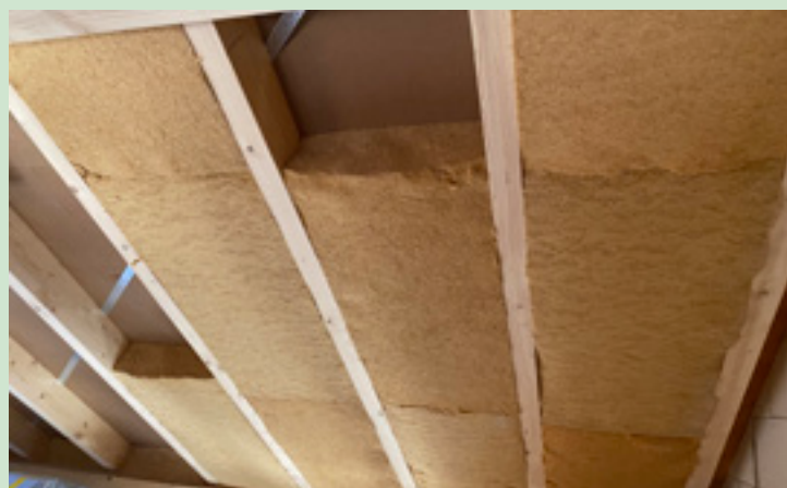
Dachausbau mit UdiFLEX ® als Zwischensparrendämmung für gesundes Raumklima
