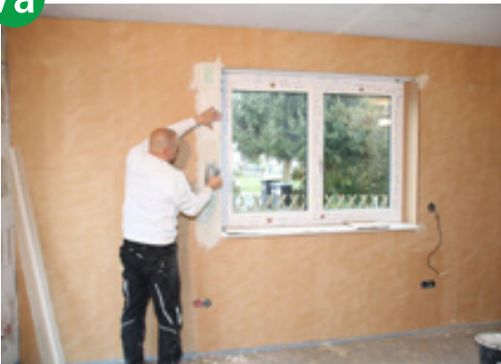
Setzen und Einspachteln der Eckschutzleisten
