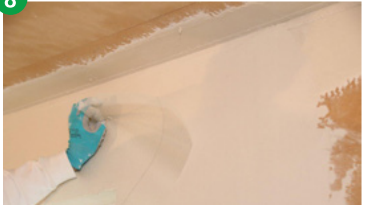
Setzen der Gewebeeckarmierung für dauerhafte Rissüberbrückung über den Ecken von Fenstern und Türen. Zweidimensionale Verstärkung der Oberfläche
