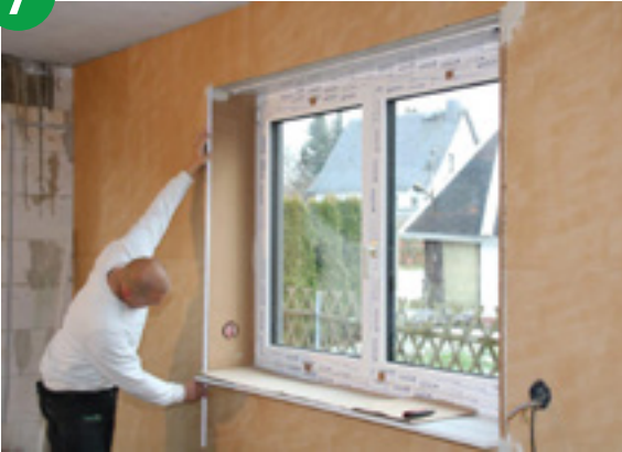
Ausmessen und Aufkleben der Laibungsplatten (20 oder 40 mm)
