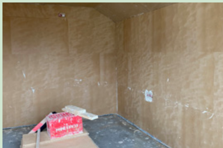
Innenwanddämmung mit UdiIN 2CM ®
