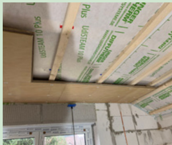
Dachausbau 1.OG Dampfbremse UdiSTEAM ® mit natürlicher Klimaausbauplatte UdiCLIMATE ® für optimalen Schallschutz
