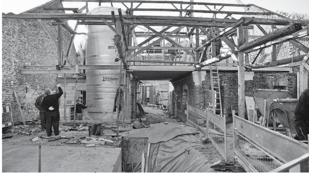
Gigantischer Warmwasserspeicher: 40.000 Liter fasst der Behälter, der im Zuge der Sanierung in den Vierkanthof „Wilde 16“ in Verlautenheide eingebaut worden ist. Aus dem alten Gut soll ein modernes Sonnenhaus werden. Foto: Andreas Herrmann
