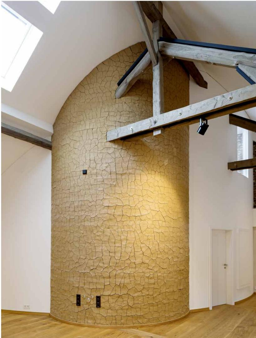
Solarwärmespeicherverkleidung mit Aachener Lehm aus Fundamentaushub
