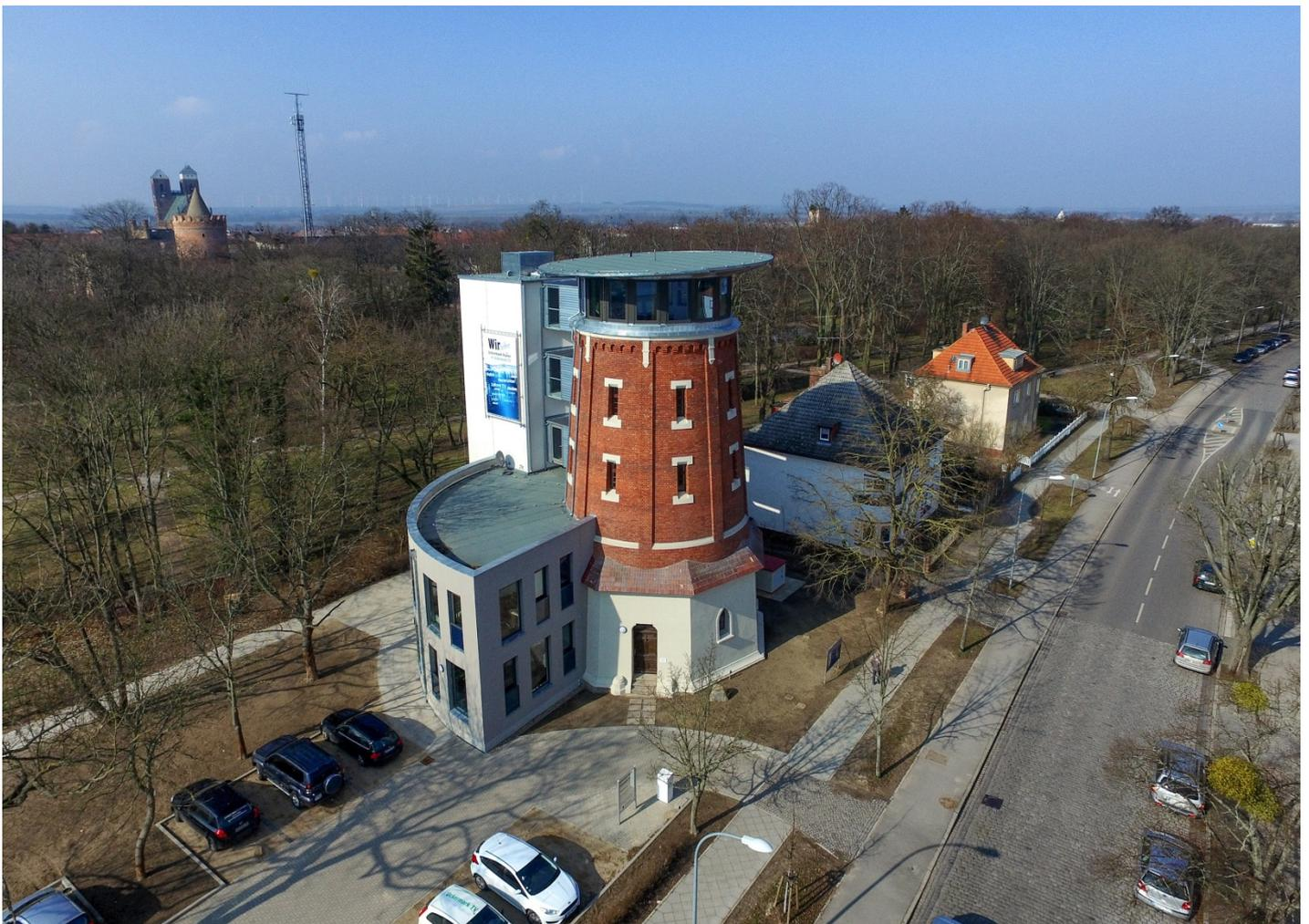
Die klassische Fassade blieb zum Glück erhalten, denn der Wärmeschutz wurde über ein hochmodernes Holzfaserdämmsystem an den Innenwänden realisiert. Auf der Suche nach einer möglichen Nutzung wurde der Turm, ergänzt durch einen zweigeschossigen Anbau und einen Treppenturm mit Aufzug, zum Mediacentrum des Nordkurier mit Redaktionsräumen des Uckermark-Kurier und dem Fernsehstudio des Uckermark-TV.
