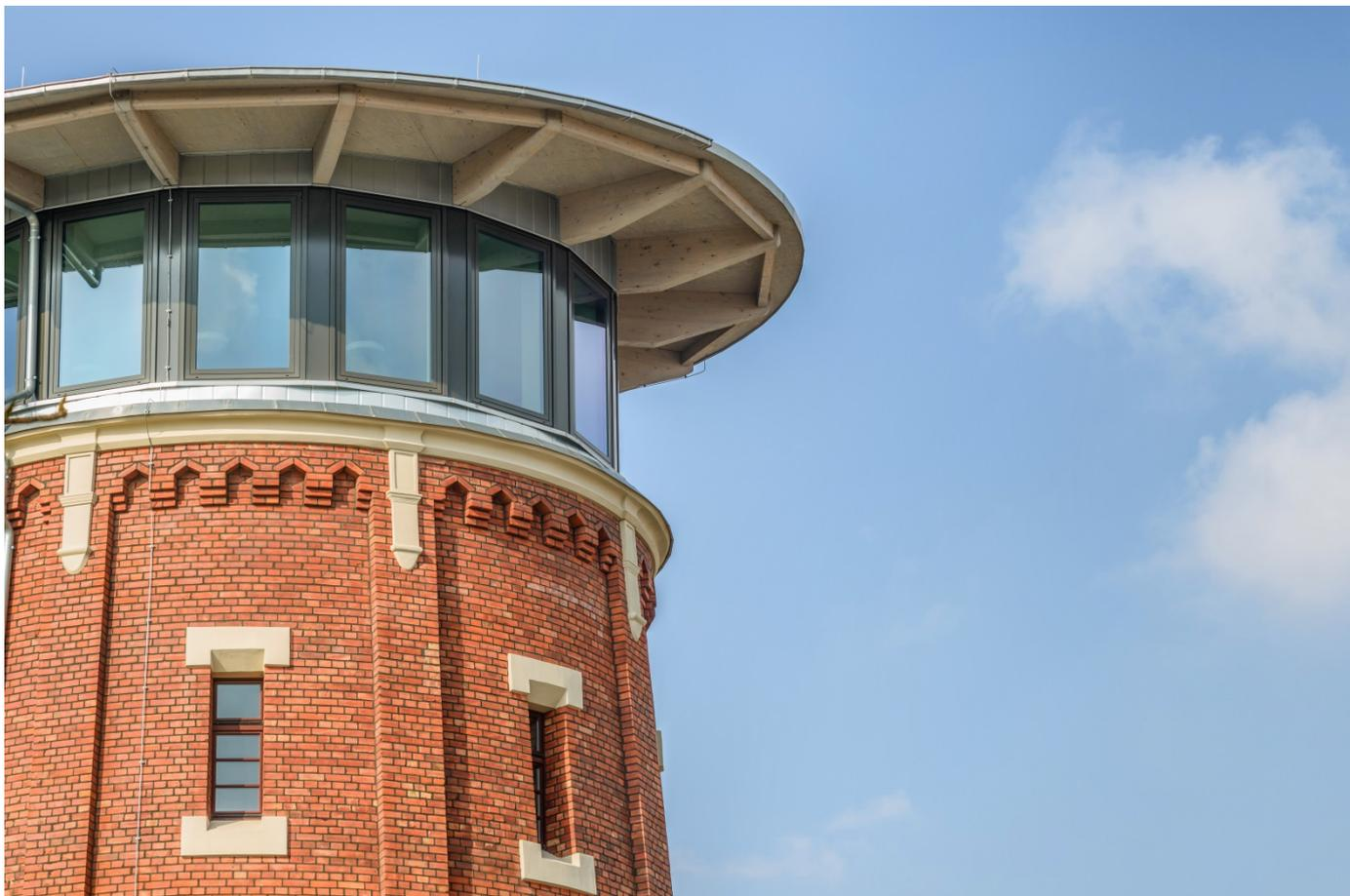
Wer sie von draußen betrachtet, kann den Reiz der neogotischen Klinkerfassade auf sich wirken lassen. Dass sie erhalten blieb, ist auch moderner Innendämmtechnik zu verdanken. Das dabei verwendete kapillar aktive Dämmsystem verhindert zuverlässig Probleme mit Feuchtigkeit, die zu Schimmel und Bauschäden führen könnten. Die Oberflächentemperatur der Wände erhöht sich um etwa 5°. Dadurch empfindet der Körper auch bei geringerer Lufttemperatur eine größere Behaglichkeit. Dank warmer Wände.
