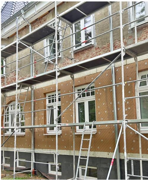
Die Fassade der Villa (Bj. 1913) wurde auf 400 m<sup>2</sup> mit dem Dämmsystem UdiRECO neu eingekleidet. In Kombination mit einer modernen Haustechnik weist das Schlösschen nun mit 54 kWh/m<sup>2</sup>a einen geringeren Primärenergiebedarf auf als ein KfW-Effizienzhaus 100.
