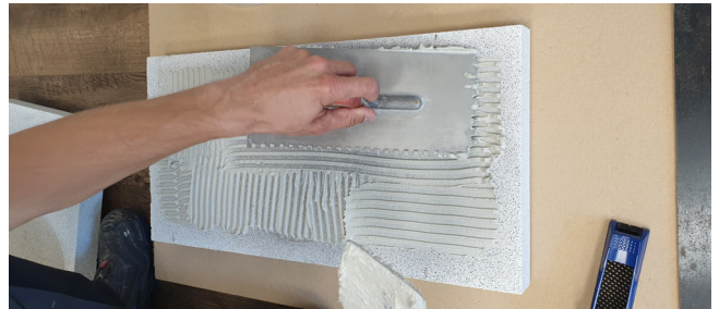
2. Mit Zahnkelle verteilen, 5 cm Abstand zur Sichtkante lassen
