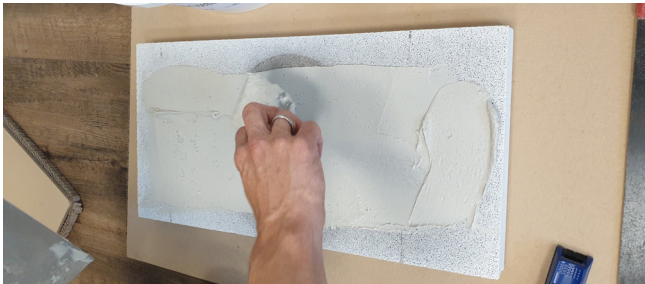
1. UdiSPEZIALKLEBER® auftragen
