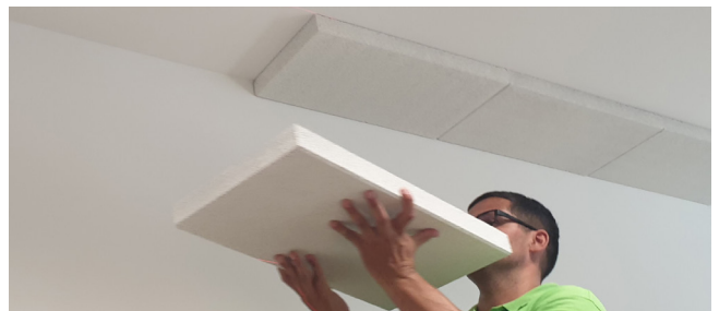
4. Mit sauberen Händen positionieren
