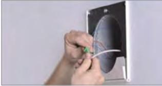
Verbinden Sie anschließend die Steckverbindung der Anschlussleitung zur **UdiAIR Lüfter-Regelung**.
