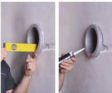
Die Wanddurchführung kann nach Fertigstellung der Wand bündig mit einem Teppichmesser gekürzt werden.
