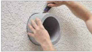
Nach Abschluss der Dämm- / Putzarbeiten entfernen Sie die Putzdeckel auf der Innen- und Außenseite. Passen Sie die Wanddurchführung dem Maß der Fertigwand an, indem Sie die Wanddurchführung mit einem Teppichmesser oder einem Heißdraht raum- und fassadenseitig wandbündig kürzen.
