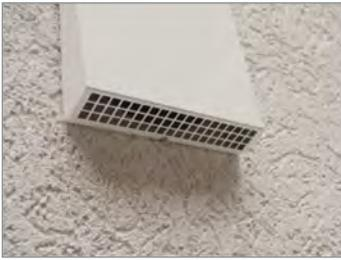
Achten Sie bei der Auswahl des Einbauortes auf die Außenansicht des Gebäudes. Damit sich die Geräte harmonisch in die Gebäudefassade einfügen, sollten die Geräte beispielsweise in gleicher Höhe / mit gleichem Abstand zu Fenstern montiert werden. Beachten Sie die Abmessungen der außen- bzw. raumseitigen Luftdurchlässe. Es wird empfohlen, um die Wanddurchführung einen **Mindestabstand von 200 mm zu angrenzenden Fassadenbauteilen / -elementen und Raumecken** einzuhalten!
