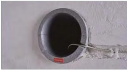
Führen Sie die Anschlussleitung (mind. 3 x 0,60 mm<sup>2</sup>) seitlich (Ansicht Raumseite) in die Wanddurchführung ein. Lassen Sie die Anschlussleitung in Länge der Wanddurchführung überstehen.
