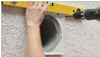
Montieren Sie anschließend die Wandkonsole der Wetterschutzhaube mit geeigneten Befestigungselementen.
