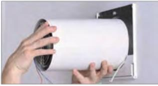
Montieren Sie die Innenwandkonsole mit geeigneten Befestigungselementen und schieben Sie die Ventilatoreinheit (Ventilator zeigt Richtung Raum) vorsichtig in die Wanddurchführung ein. Achten Sie darauf, dass die Anschlussleitung des Ventilators dabei nicht geknickt / beschädigt wird. Über das Schutzgitter kann die Ventilatoreinheit bei der Montage ausgerichtet und zu Wartungszwecken wieder aus der Wanddurchführung rausgezogen werden.
