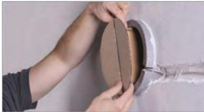
Verschließen Sie die Wanddurchführung auf der Innen- und Außenseite mit den mitgelieferten Putzdeckeln, um eine Verschmutzung der Wanddurchführung zu vermeiden
