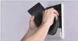
Legen Sie die Schalldämmmatte umlaufend mit einem Abstand von mind. 3 cm zur Ventilatoreinheit raumseitig ein.
