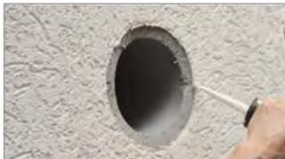
Zum Schutz vor Wassereintritt in den Wanddurchbruch muss der fassadenseitige Übergang zur Wanddurchführung umlaufend mit einem geeignetem Dichtmaterial abgedichtet werden!
