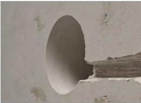
Erstellen Sie eine Kernlochbohrung im Durchmesser  $\geq 200$  mm, bzw. mauern Sie die Wanddurchführung eckig ins Mauerwerk. Stellen Sie in beiden Fällen einen Kabelschlitz für die Anschlussleitung her.
