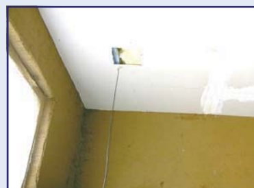
Abb. 66: Gipskartonunterdecke, 2 x 12,5 mm
