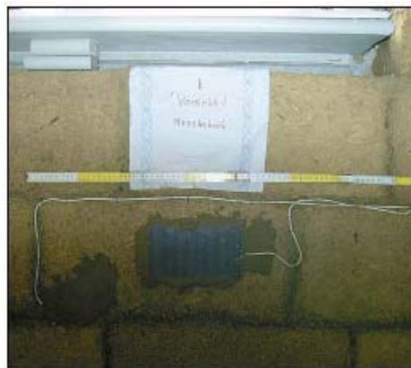
Abb. 174: Wandfeld nach dem Einbau der
