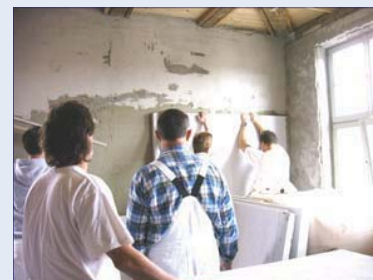
Abb. 48: Anbringen der Calsitherm-Klimaplatte unter Anleitung
