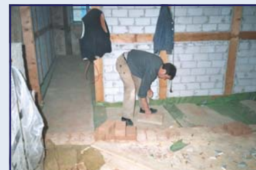
Abb. 42: Bsp. „schwere“ Bauart: Deckenfüllung mit Grünlingen
