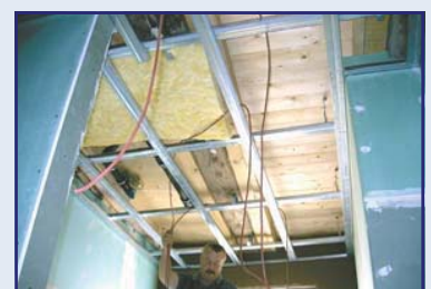
Abb. 75: Federschiene mit Federabhängung und 40 mm Mineralwolleinlage
