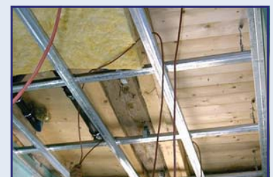
Abb. 70: Federschiene mit Federabhängung und 40 mm Mineralwolleinlage
