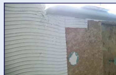
Abb. 112: Multigrund in Gewebe auf der Holzweichfaserplatte
