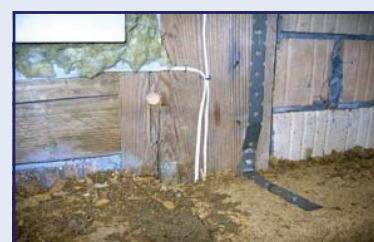
Abb. 83: Befestigung der Innenschale aus Holzleichtlehmsteinen
