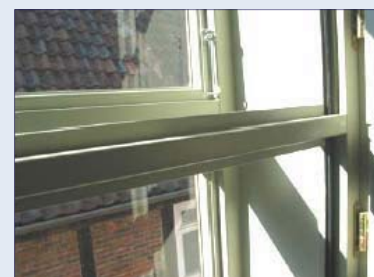
Abb. 142: Kastenfenster Raum 3.04 (Südseite), Dichtungsband im Kämpfer entfernt
