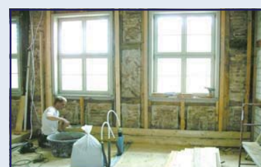
Abb. 92: Verfüllen der Schalbretter mit Cellco-Wärmedämmlehm
