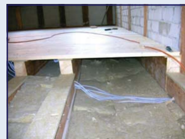
Abb. 43: Bsp. „leichte“ Bauart: Deckenfüllung mit Mineralwolle
