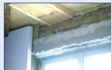
Abb. 102: Plattenanschluss im Decken- bzw. Sturzbereich
