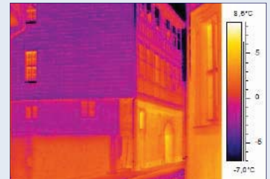
Abb. 139, 140: Das massive Erdgeschoss ohne Innendämmung und der Sockel heben sich gegenüber dem Fachwerk durch höhere Temperaturen hervor.
