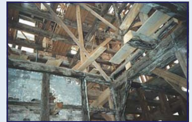
Abb. 32: Innenaufnahme aus dem Erdgeschoss in Blickrichtung Westgiebel, Herbst 2003
