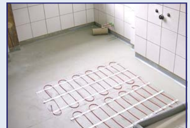
Abb. 73: elektr. Heizmatten auf grundierten Knauf-Brio-Estrich-
