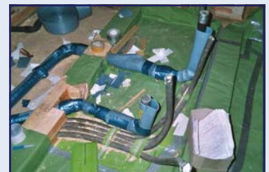
Abb. 56: Schallummantelte Sanitärleitungen
