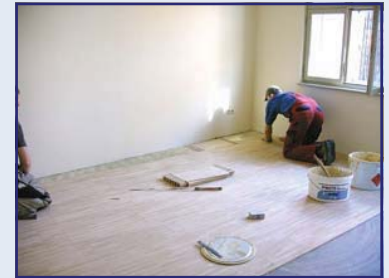
Abb. 67: Verlegen des Parkettbodens
