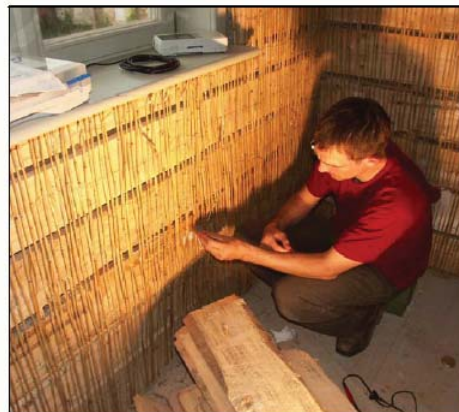
Abb. 176: Einbau der Sensoren 3 und 4
