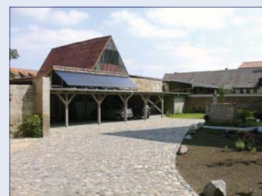
Abb. 53: links: Carports mit Solar-Kollektoren, rechts: Mietergärten
