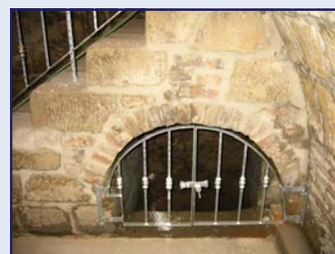
Abb. 18: Kellertreppe mit Brunnengitter. Der Brunnen bleibt in seiner ursprünglichen Form erhalten.
