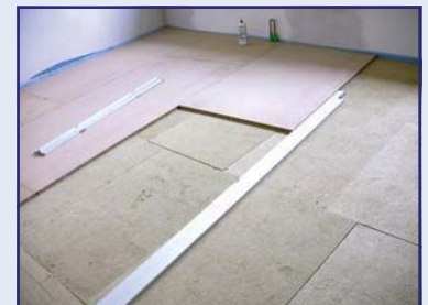
Abb. 68: Spanplatte auf Trockenestrich und Ausgleichsschüttung
