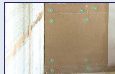
Abb. 111: Plattenanschluss mit Verdübelung an der Wand
