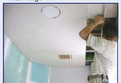
Abb. 76: Gipskartonunterdecke, 2 x 12,5 mm
