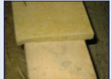
Abb. 54: TSD-Streifen 1 cm über Deckenbalken überlappend
