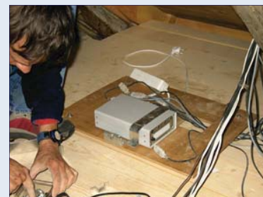
Abb. 120: Installation des Dataloggers auf dem Dachboden
