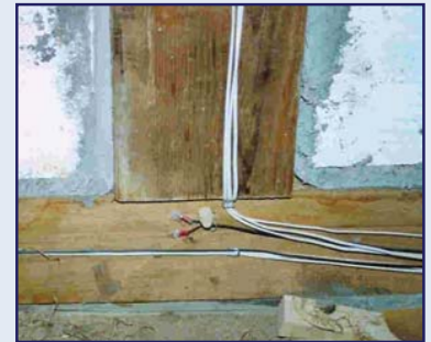
Abb. 3: Bsp. Holzfeuchtemessstelle
