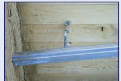
Abb. 55: Federabhängiger für Unterdecke
