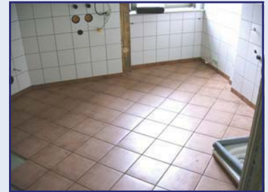
Abb. 72: Verlegen der Bodenfliesen, diagonal
