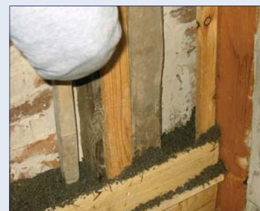
Abb. 47: Einstampfen des Haa-cke-Cellco-Wärmedämmlehms
