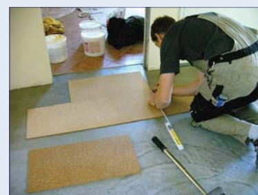
Abb. 52: Verlegen der Kork-Fußbodenbeläge
