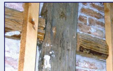
Abb. 91: Senkrechte Unterlattung zur Aufnahme der Schalbretter
