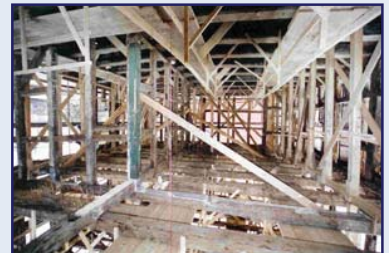
Abb. 33: Obergeschoss im entkernten und gesicherten Zustand, Herbst 2003
