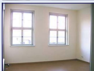
Abb. 94 bis 100: Fortschritt der Innendämm-Maßnahme
