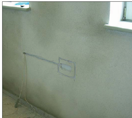
Abb. 180: Wandfeld vor dem Einbau der Sensoren 3 und 4
