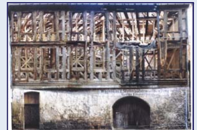
Abb. 12: Straßenansicht 2002 vor der Sanierung
