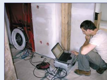
Abb. 123: Blower Door im Einsatz, Messung der Luftwechselrate in Wohnung 1
