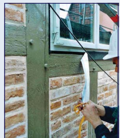
Abb. 39: Anbringen von Dichtvlies außen, 2. Obergeschoss - Kastenfenster
