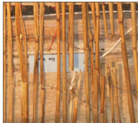
Abb. 178: Wandfeld nach dem Einbau der Wärmestromplatte und des Temperatursensors
