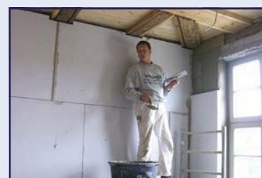
Abb. 103: Wandlage Calsitherm® - Klimapplatten
