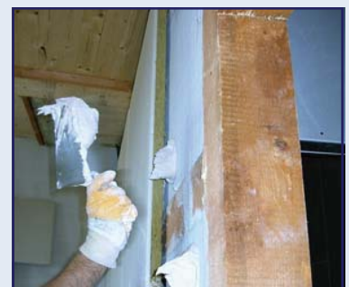
Abb. 58: Anplastern der Sandwichplatte KNAUF W624 an Fachwerkwand
