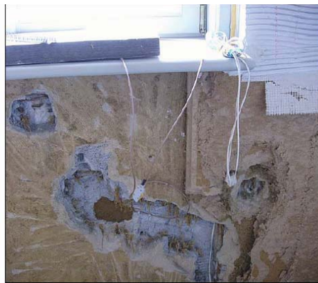
Abb. 184: Neueinbau Messfühler 2
