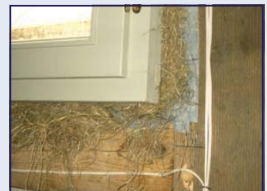
Abb. 38: Hanfdichtung am Kastenfenster
