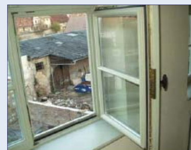
Abb. 143: Isolierglasfenster Raum 3.06 (Nordseite)
