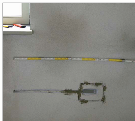
Abb. 182: Wandfeld nach dem Einbau der Wärmestromplatte und des Temperatursensors
