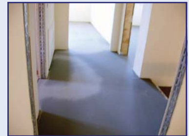
Abb. 78: Gussasphalt-Trockenestrich im Flur 1. OG
