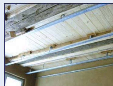
Abb. 65: Federschiene mit Federabhängung
