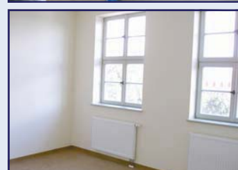
Abb. 104 bis 110: Fortschritt der Innendämm-Maßnahme mit
