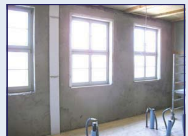
Abb. 57: Calsitherm-Streifen am Anschluss einer neuen Innenwand
