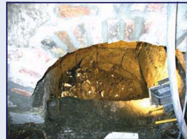
Abb. 15: Brunnen: Aushub des Verfüllmaterials
