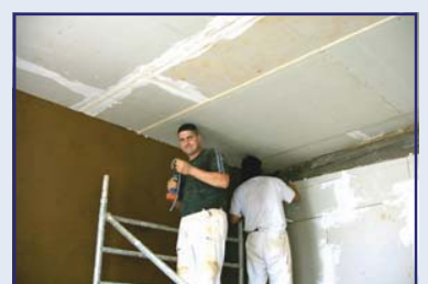
Abb. 71: Gipskartonunterdecke, 2 x 12,5 mm
