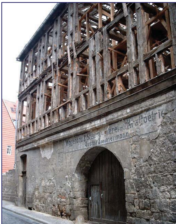
Abb. 36: Straßenansicht im Frühjahr 2003 nach ersten Sicherungs-
