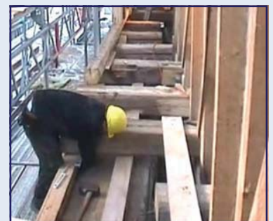
Abb. 34: Zimmererarbeiten an den Balkenköpfen in traditioneller Technik
