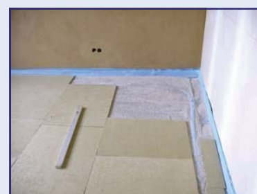
Abb. 63: Trockenestrich auf Ausgleichsschüttung und Rieselschutz
