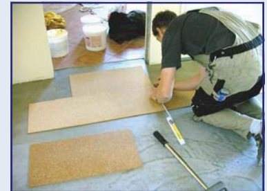
Abb. 77: Verlegen der Korkplatten
