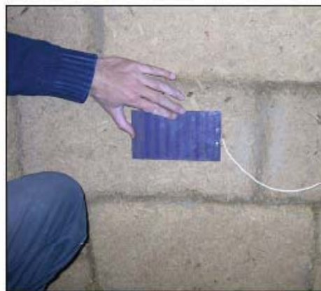
Abb. 172: Wandfeld vor dem Einbau der Wärmestromplatte
