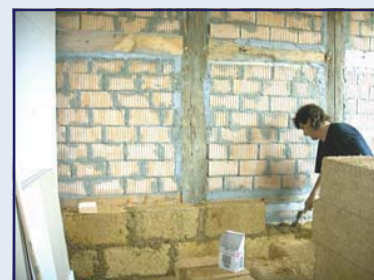
Abb. 84: Aufmauern der Holzleichtlehmsteine
