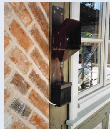
Abb. 50: Schlagregenkasten an der Hoffassade
