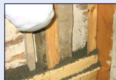
Abb. 93: Einstampfen des Cellco-Materials
