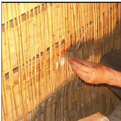
Abb. 177: Befestigung des Temperatursensors
