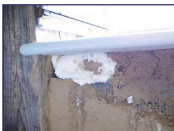
Abb. 40: Bauschaum als Füllmaterial in Holzleichtlehmschale
