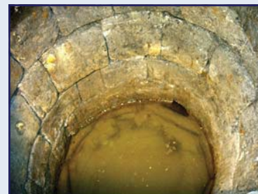
Abb. 17: Freigelegter Brunnen unter Kellertreppe
