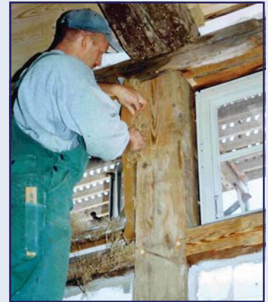
Abb. 37: Einstopfen der Hanfdichtung, Erdgeschoss - Isolierglasfenster
