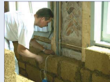
Abb. 46: Hinterstopfung der Holzlehmsteine mit Leichtlehmbruch und Lehm Mörtel
