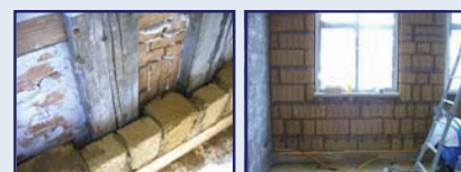
1. OG - WE 2, Lehmsteine + erg. Wandheizung
