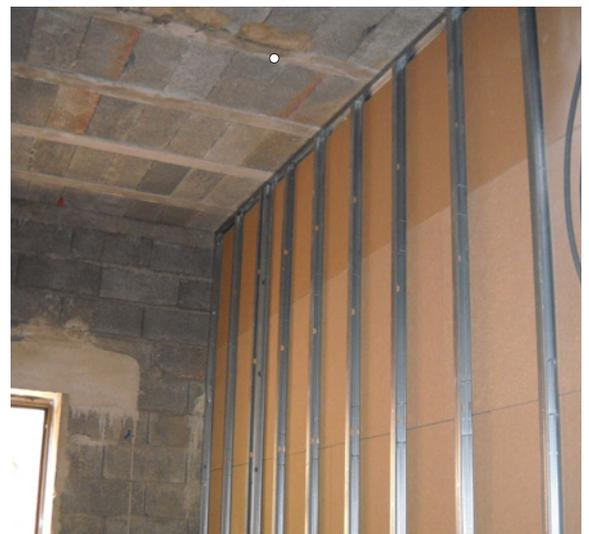
Holzständer- oder CW-Profile werden gestellt und mit UdiFLEX® Holzfaserdämmung verfüllt. Beidseitige Montage mit UdiCLIMATE® Innenausbaudämmplatten schafft Ruhe und Wohlfühlklima in Ihren Räumen. Für die Ergänzung zum Sortiment fordern Sie bitte unsere kostenlose UdiPRODUKTÜBERSICHT® an.
