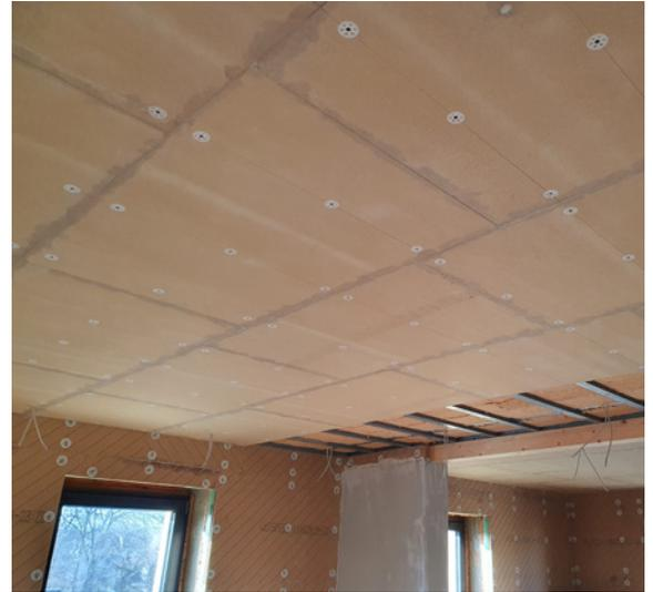
Der Aufbau für eine Holzbalkendecke ist sichtlich einfach. UdiCLIMATE® wird von unten auf den Holzbalken montiert. Zwischen den Deckenbalken wird der flexible Holzfaserdämmstoff UdiFLEX® eingebracht. Die Trittfläche wird mit OSB, Rauspant oder Schalungsbrettern belegt. Weitere Aufbaumöglichkeiten aus dem UdiSTEP® System sind möglich je nach Anforderung, Fliesen, Teppich, Parkett.
