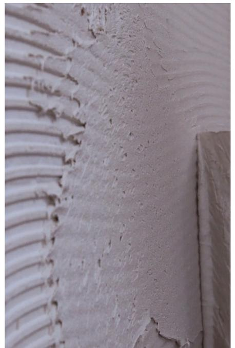
Die Nut- und Federverbindung wird zur Erhöhung der Scheibenwirkung zusätzlich mit **UdiCLIMATE<sup>®</sup> Systemkleber** verklebt.
