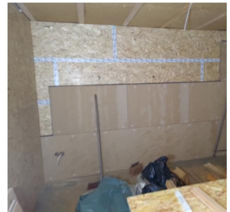
Der Wandaufbau von außen nach innen gestaltet sich wie folgt: **UdiTOP®**, **UdiFLEX®**, OSB-Platte, direkte Beplankung mit Installationsebene und **UdiCLIMATE®** für den Wand- und Deckenbereich sowie für alle Trennwände.
