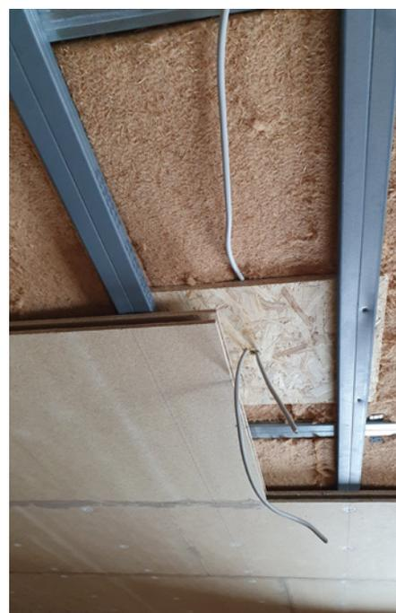
Befestigung der **UdiCLIMATE<sup>®</sup>** mit der Climateschraube auf allen tragfähigen Untergründen, wie Holz-, Metallständer, auf die Balkenlage oder direkt durch vorhandene Gipskartonkonstruktion. Sparrenachsabstand bis 80 cm möglich, Schraubenbedarf: ca. 4 Stück/lfm bzw. 6-9 Stück/m<sup>2</sup>
