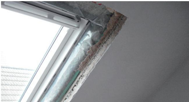
Bei dieser Variante erfolgt kein Rückbau, der Bestand bleibt komplett bestehen. Gründe hierfür können im Arbeitsaufwand, nicht gewünschter Eingriff in die Dachkonstruktion oder beim Vermieter und Besitzer liegen. Aber genau das ist eine Möglichkeit im Bestand die UdiCLIMATE<sup>®</sup> direkt auf die vorhandene Unterkonstruktion aufzubringen, um den gewünschten Effekt für ein neues Wohlfühlklima im Raum zu erzielen.
