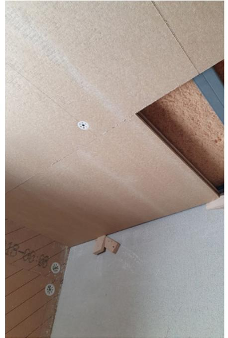
Nahezu verschnittfreie Verlegung möglich, da Nut und Feder an vier Seiten verwendet werden kann.
