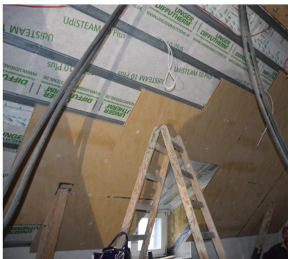
Dachausbau als Untersparrendämmung
