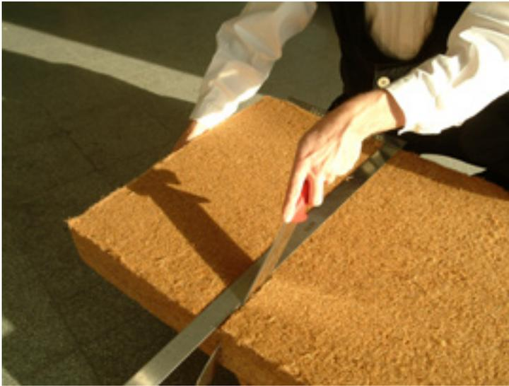
Für einen einfachen verschnittfreien Zuschnitt vor Ort empfehlen wir den Einsatz des **UdiFLEX®**-Dämmstoffmessers. Das perfekt abgestimmte Dämmstoffmesser lässt eine saubere Schnittkante bei sehr einfacher Handhabung zu. Es wird aufwendig aus hochwertigem Edelstahl mit Kullenschliff gefertigt.
