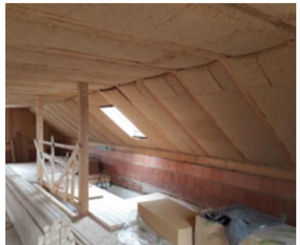
Beim Zuschnitt und Verarbeitung der flexiblen Holzfaserdämmplatte **UdiFLEX®** fallen Stäube an. Wird über Kopf verarbeitet, so sollte eine handelsübliche Staubmaske getragen werden.
