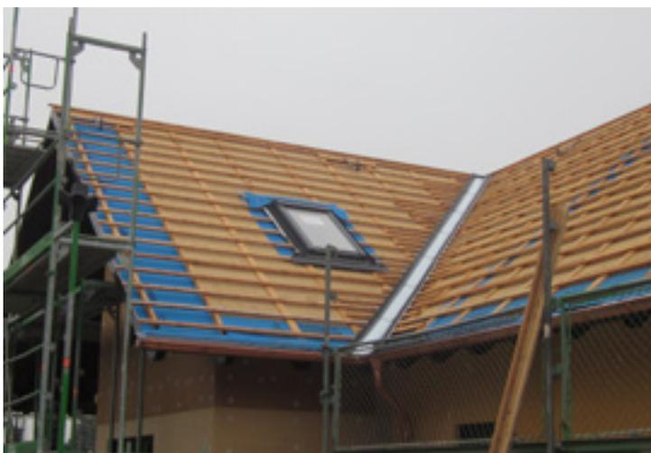
ANBAU UdiTOP® Dachplatten Anschluss an Bestand von außen
