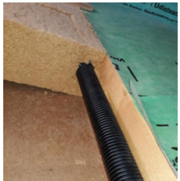
Leerrohr für zukünftige Kabelführung mit einplanen. z.B. für Solaranschluss
