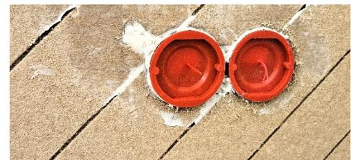
Der Bereich, in dem sich die Zuleitung befunden hat, kann mittels einem Holzfaser-Kleber-Gemisch verschlossen werden. Für die weiterführenden Spachtelarbeiten sollten Schutzkappen verwendet werden.
