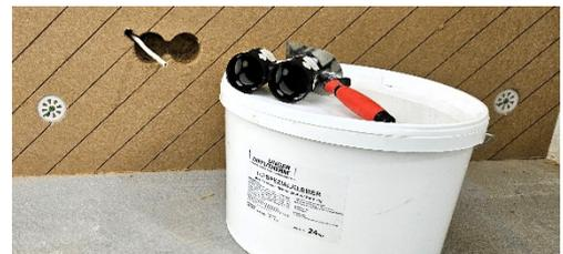
Die Bohrungen werden von Staub befreit um darauf folgend geschlossene Unterputzgerätedosen mittels **UdiSPEZIALKLEBER** einzukleben.
