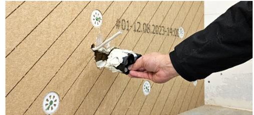
Der Kleber wird sowohl auf die Innenseiten der Bohrungen als auch auf die Unterputzgerätedosen aufgetragen.
