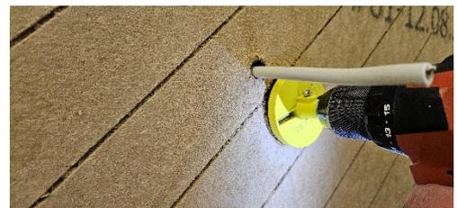
Nachdem alle Platten montiert und ausgerichtet sind werden die notwendigen Öffnungen angezeichnet und mittels Lochkreissäge gebohrt.
