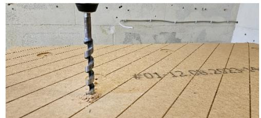
Während der Plattenmontage erfolgt eine Bohrung mittels Spiralbohrer um die Leitung durch die Platte zu führen. Wichtig dabei, die Position der Durchführung sollte leicht versetzt zur zukünftigen Dose platziert sein.
