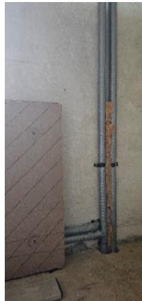
Nun können die Platten montiert werden. Es ist darauf zu achten, dass sämtliche Hohlräume geschlossen sind. Neben dem Bereich Heizleitung zur Wand ist auch zwischen den Heizleitungen (siehe Bild) flexibel auszustopfen. Um im weiteren Montageverlauf keine Beschädigungen zu verursachen sollte der Leitungsverlauf unmittelbar nach dem Platzieren der Platten auf der Oberseite markiert werden. Die weitere Verdübelung und das Ausrichten erfolgt dann auf Grundlage der Standard- montagevorgaben.
