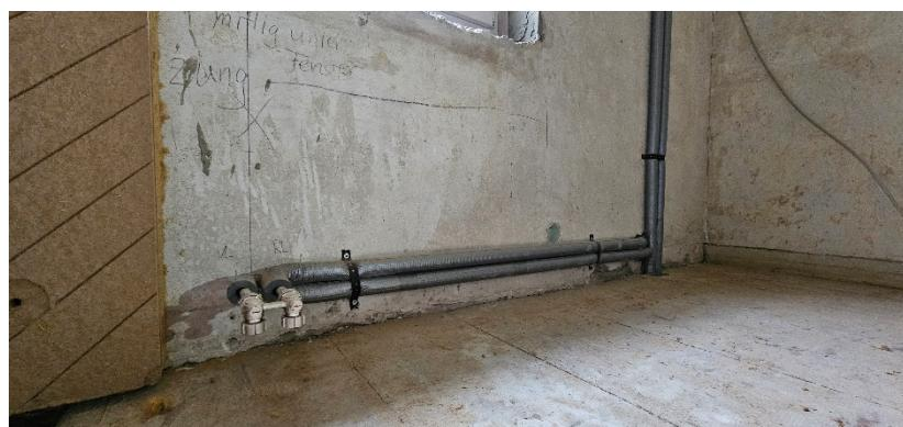
Die Heizleitungen sind fertig installiert und an der Wand fixiert. Wichtig ist, dass sich zwischen Leitung und Außenwand Dämmmaterial befindet. Um dies sicherzustellen, können Montageschellen verwendet werden, welche den notwendigen Abstand halten. Dieser wird dann im Folgenden mit Reststücken der flexiblen Ausgleichsschicht der Dämmplatte **UdRECO** ausgestopft.
