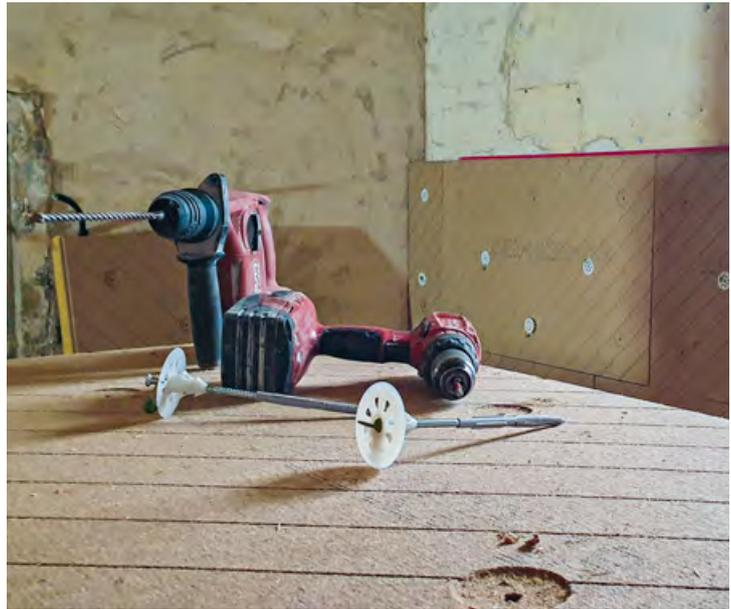
5 Ein Stelldübel mit integriertem Teller drückt die Dämmplatte in die richtige Position. Beim Verschrauben verkralen sich die Widerhaken im Dämmstoff. Die Holzfasern werden unter Aufnahme hoher Zugkräfte gegen die Wand gepresst.
