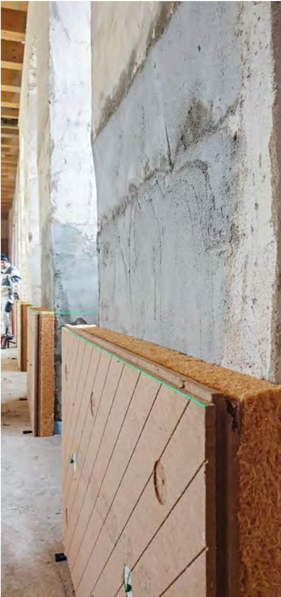
4 Die Innenseiten der Außenwände wurden mit dem Holzfaser-Dämmsystem UdiReco gedämmt. Ohne Unterkonstruktion oder Klebstoff und ohne den Putz vorher abschlagen zu müssen. Die biegsamen Dämmplatten schmiegen sich mit der weichen Seite an die Mauer und gleichen Unebenheiten, Verwerfungen und leichte Neigungen des Untergrunds bis zu zwei Zentimetern aus.
