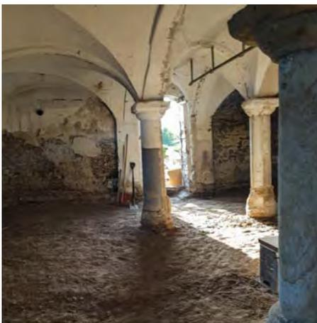
Das Kreuzrippengewölbe auf Sandsteinsäulen war mit Trennwänden verbaut, die Decke abgehängt bei nur noch 2,10 Metern Raumhöhe.
