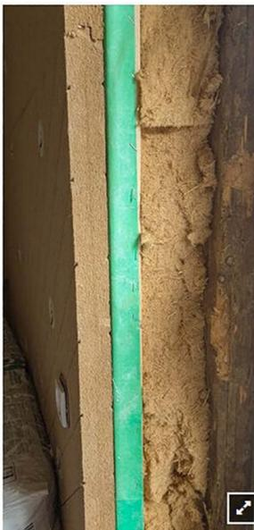
Aufbau der Fachwerkwände aus 10 Zentimeter Holzfaserdämmstoff (UdiFlex), feuchtevariabler Dampfbremse (UdiSteam) und vier Zentimeter starker putzfähiger Holzfaserdämmplatte (UdiSpeed). (Bild: UdiDämmsysteme)
