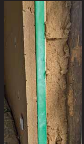
Aufbau der Fachwerkwände aus 10 Zentimeter Holzfaserdämmstoff („Udi Flex“), feuchtevariabler Dampfbremse („Udi Steam“) und vier Zentimeter starker putzfähiger Holzfaserdämmplatte („Udi Speed“)
