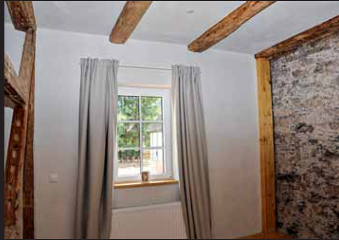
Die Bruchsteinmauern im Erdgeschoss wurden mittels Holzfaserdämmplatten mit integriertem Untergrundaussgleich gedämmt. Der U-Wert beträgt jetzt 0,354 W/(m 2 ·K), zuvor 1,712 W/(m 2 ·K)
