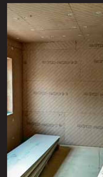
Aufbau der Fachwerkwände aus 10 Zentimeter Holzfaserdämmstoff („Udi Flex“), feuchtevariabler Dampfbremse („Udi Steam“) und vier Zentimeter starker putzfähiger Holzfaserdämmplatte („Udi Speed“)
