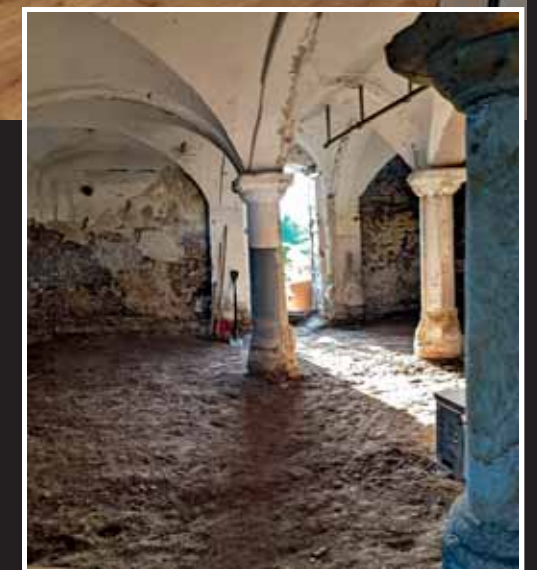
Das Kreuzrippengewölbe auf Sandsteinsäulen war mit Trennwänden verbaut, die Decke abgehängt bei nur noch 2,10 m Raumhöhe
