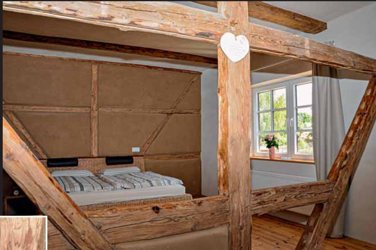
Die Bruchsteinmauern im Erdgeschoss wurden mittels Holzfaserdämmplatten mit integriertem Untergrundaussgleich gedämmt. Der U-Wert beträgt jetzt 0,354 W/(m 2 ·K), zuvor 1,712 W/(m 2 ·K)
