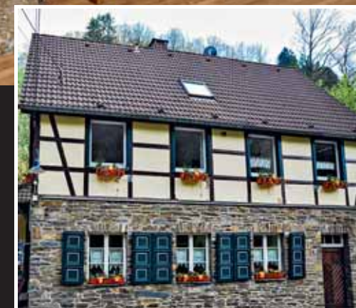
Das über 400 Jahre alte Gehöft schien dem Verfall preisgegeben. Heute erfüllt es Niedrighausstandards (Fotos: Udi Dämmsysteme)
