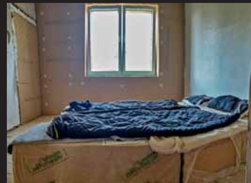
Wenn es auf der Baustelle mal wieder spät wurde: Die flexiblen Holzfasermatten dienen dem Bauherrenpaar sogar als bequemes Notbett
