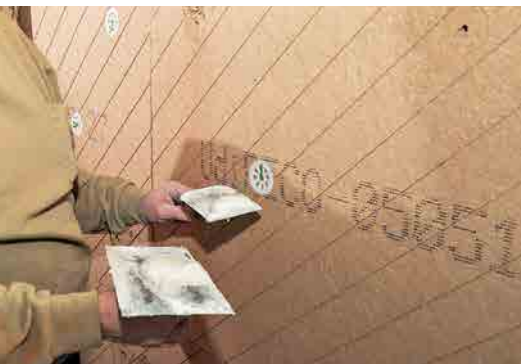
13 + 14 Auf die ausgerichteten Dämmelemente wird ein klimaregulierender, mineralischer Funktionsspachtel aufgebracht, der integraler Bestandteil des Dämmsystems ist. Der frische Armierungsspachtel kann direkt auf die trockenen und staubfreien Holzfaserdämmelemente aufgebracht werden.
