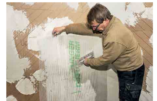
18 Das rissüberbrückende Armierungsgewebe wird in den frischen Armierungsspachtel eingebettet. Die gesamte Wand muss vollflächig armiert und verspachtelt werden. Darauf kann tapeziert, gestrichen, gefliest oder auch verputzt werden.
