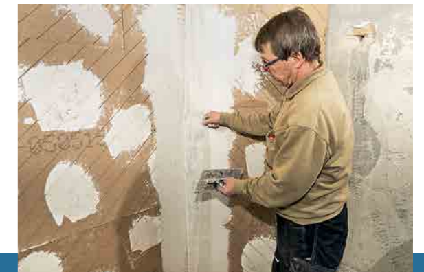
17 Um Langlebigkeit und Stabilität sicherzustellen, werden sowohl Innen- als auch Außenecken mit Eckschutzleisten stabilisiert.
