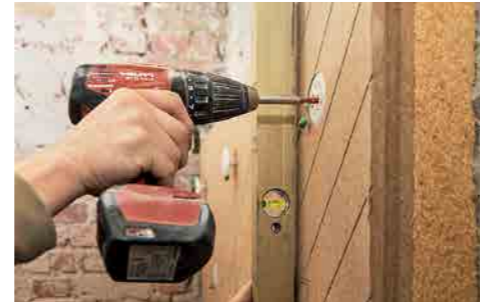
10 Das Ausjustieren der Fläche erfolgt mittels Akkuschrauber. Die zum System gehörenden Stelldübel ermöglichen den Ausgleich von Unebenheiten in Abhängigkeit zur Dämmstärke im Untergrund von bis zu plus/minus 2 cm. Die Stelldübel werden eingeschraubt, bis der Rückholverschluss einrastet und sich der Dübelkopf in obere Dämmebene verkrallt. Die Holzfaserdämmplatte wird mit der Wasserwaage oder dem Laser justiert.
