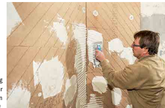
16 Die Verwendung einer Zahnkelle sorgt für einen gleichmäßigen Materialauftrag.
