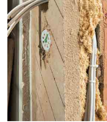
12 Die Kabelführung kann einfach auf dem Mauerwerk erfolgen. Der flexible Untergrundaussgleich des Holzfaserdämmelements passt sich problemlos an und sorgt für eine hohlraumfreie Montage.
