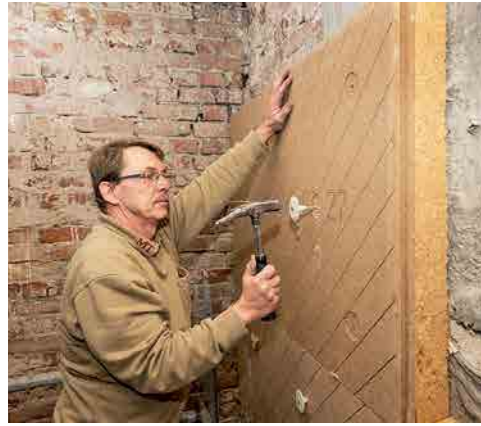
8 Gegebenenfalls kann mit leichten Hammerschlägen die endgültige Setzposition erreicht werden.
