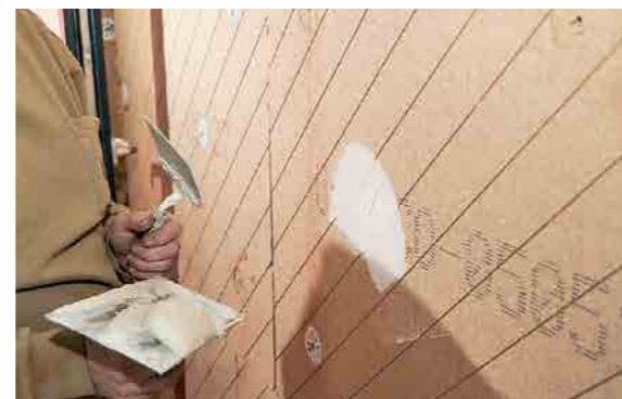
10 Das Ausjustieren der Fläche erfolgt mittels Akkuschrauber. Die zum System gehörenden Stelldübel ermöglichen den Ausgleich von Unebenheiten in Abhängigkeit zur Dämmstärke im Untergrund von bis zu plus/minus 2 cm. Die Stelldübel werden eingeschraubt, bis der Rückholverschluss einrastet und sich der Dübelkopf in obere Dämmebene verkrallt. Die Holzfaserdämmplatte wird mit der Wasserwaage oder dem Laser justiert.
