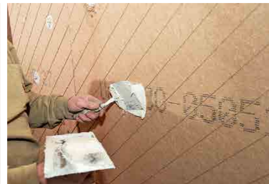
13 + 14 Auf die ausgerichteten Dämmelemente wird ein klimaregulierender, mineralischer Funktionsspachtel aufgebracht, der integraler Bestandteil des Dämmsystems ist. Der frische Armierungsspachtel kann direkt auf die trockenen und staubfreien Holzfaserdämmelemente aufgebracht werden.
