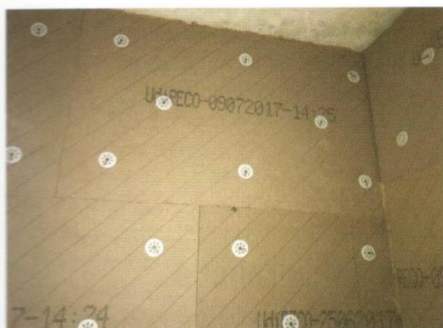
**Bild 4** Der Clou des Dämmsystems System ist ein patentierter Stelldübel mit einem Teller am Kopfende. Beim Verschrauben krallen sich Widerhaken in die Holzfasern.
