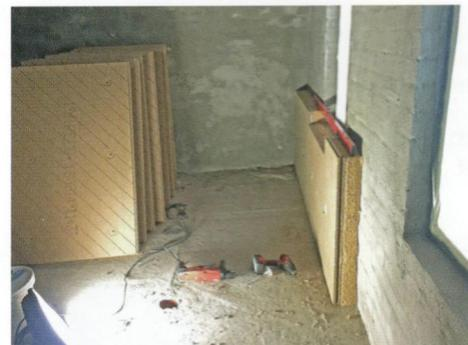
**Bild 3** Die unebenen alten Ziegelwände waren eine besondere Herausforderung. Daher kam das Holzfaser-Innendämmsystem Udi In Reco mit Untergrund-Ausgleich zum Einsatz.
