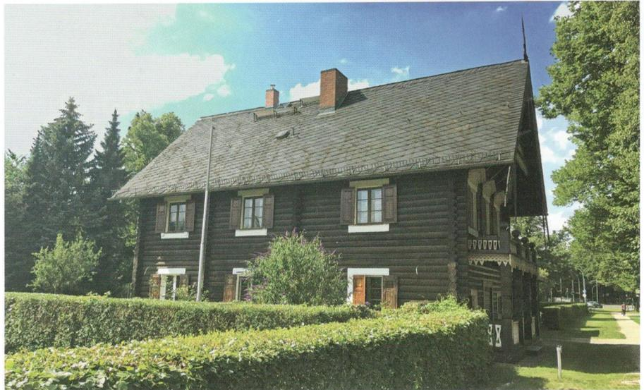
**Bild 1** Bei den Wänden handelt es sich um ausgemauerte Fachwerk-Konstruktionen mit vorgesetzten, längshalbierten Holzstämmen.
