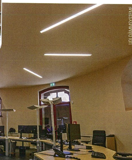
Die Mitarbeiter im umgebauten Wasserturm schwärmen vom wunderbaren Raumklima. Hier das Dachgeschoss.
