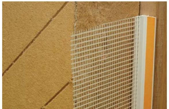
**UdiARMIERUNG**® Putzanschlußleiste LATE setzen.
