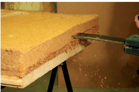
Höhere Unebenheiten oder Vorsprünge des Untergrundes können vorher im unteren Teil des Dämmelementes herausgeschnitten werden (filetieren.)
