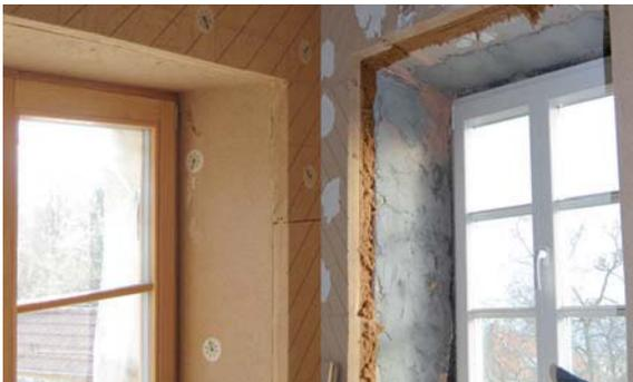
Sämtliche Öffnungen, wie Fenster und Türen werden mit Laibungsdämmplatten abschließend verkleidet.
