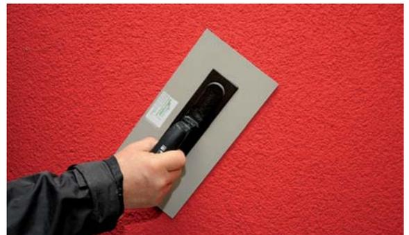
Die Strukturbildung ist abschließend von Hand durchzuführen oder auch maschinell mit dosierbaren Putzmaschinen aufzutragen. Die fertige Struktur muss gleichmäßig aussehen, kann aber etwas variieren, da individuelle Handwerksleistung.
