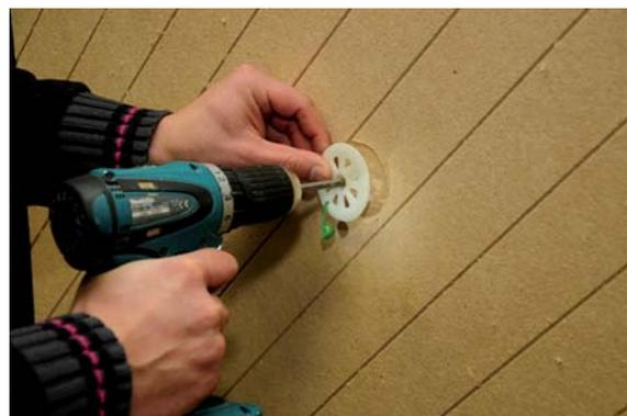
Tellerkopf beim Einschrauben festhalten, um ein Mitdrehen zu Vermeiden. Dübelkopf sitzt perfekt, wenn dieser bündig mit der Oberfläche abschließt. Als thermische Trennung unbedingt den grünen Abschlussknopf in die dafür vorgesehene Öffnung stecken.
