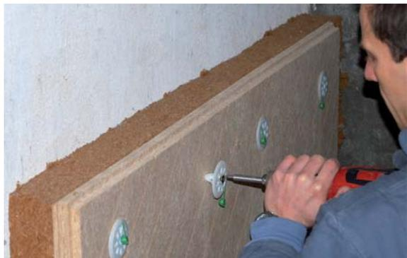
Die gezielte Einflussnahme auf das Feuchtigkeitsfeld mit dem kapillar aktiven Dämmsystem **UdiIN RECO®** verhindert Probleme mit Feuchtigkeit, die zu Bauschäden führen könnten. Mit diesem System wurde eine einfache und sichere Lösung entwickelt, die den Anforderungen der Energieeinsparung gerecht wird und ein gesundes Raumklima ermöglicht. Der Einsatz wird sowohl für dünne Fachwerkhäuser als auch für dicke Schlossmauern möglich.
