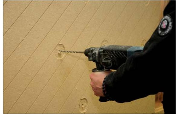
Beachten Sie beim Bohrvorgang, dass die Fasern im Loch des Dämmelementes sauber ausgespült werden müssen. Dazu einfach den Bohrvorgang nochmal nur in der oberen Dämmplatte wiederholen.
