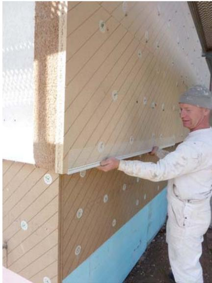
Nach erfolgter Justierung der **UdiRECO®** Dämmelemente wird das **UdiBASE®** Aufsteckprofil aufgesteckt und bündig eingespachtelt.
