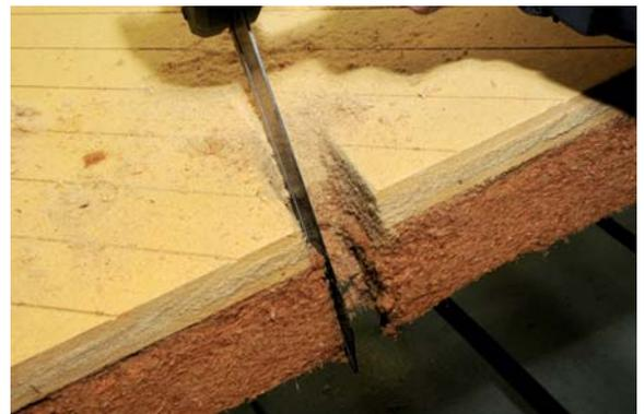
Untere, flexible Dämmebene auf Übermaß zuschneiden (Überstand zur Putzträgerene).
