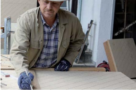
Mithilfe einer Schablone lässt sich das Dübelbild exakter durchführen. Zum perfekten wurde werksseitig bereits ein Dübelbild im **UdiRECO®** Dämmelement
