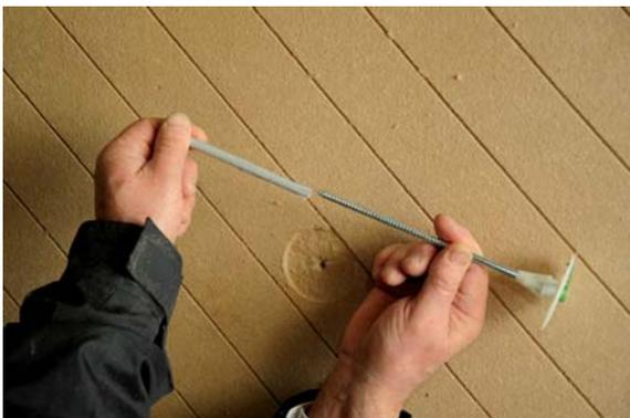
Der **UdiMONTAGE® SDM** (Stelldübel Mauerwerk) wird in zwei Teilen geliefert. Die Schraube ist mit ca. 2 Umdrehungen in die Dübelhülse einzuschrauben.
