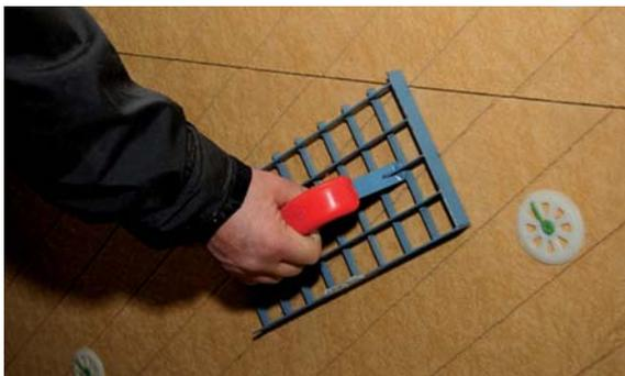
Unebenheiten bei Plattenstößen werden mit einem Gitterrobot (im Bild) oder mit elektrischem Tellerschleifer egalisiert, um bei den nachträglichen Armierungs- und Spachtelarbeiten eine gleichmäßige Auftragsstärke zu gewährleisten.
