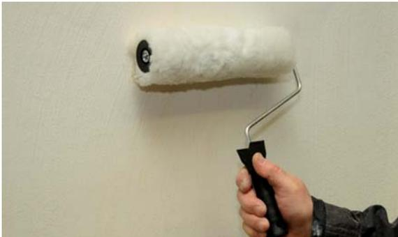
Verarbeitungsfertigen Putzgrund entsprechend dem Farbton und dem System passend aufrollen
