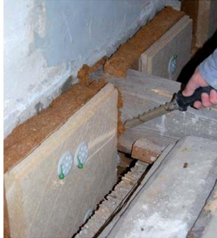
Anschlüsse sind mit Holzfaser Restdämmmaterial press zu verstopfen.
