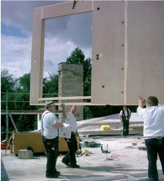
Im Massivholzbau stabilisiert sich mit dem **UdiRECO® Holzfaser Dämmelement** die Holzgleichsfeuchte. Es stellt sich ein außergewöhnlich gutes behagliches Raumklima ein. Auf Dampfsperren innenseitig der Außenwände kann generell verzichtet werden.
