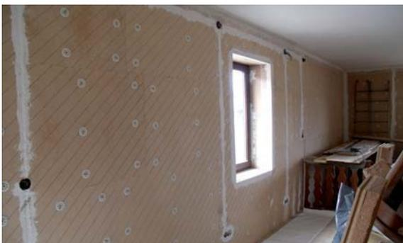
Für Elektroleitungen können senkrecht oder waagrecht Fräsungen vorgenommen werden. Alternativ kann auch das Kabel im Untergrund befestigt und überdämmt werden.
