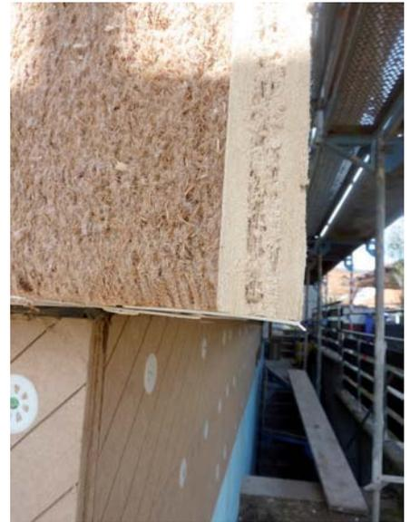
Es entsteht ein sauberer und thermisch einwandfreier Sockelabschluss mit integrierter Tropfnase zum Schutz vor eindringender Feuchtigkeit, durch Regen oder Schnee.
