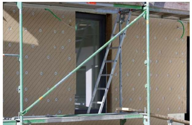
Je Dämmelement werden 8 Dübel gesetzt. Das entspricht einem Verbrauch von 10 Stk/m<sup>2</sup>.
