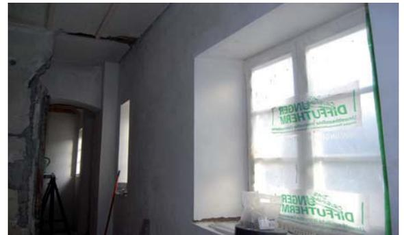
Als sauberer Putzanschluss wird die selbstklebende *Udi*ARMIERUNG® Putzanschlussleiste **INSIDE** auf die Rahmen geklebt und mit *Udi*MULTIGRUND® verspachtelt.
