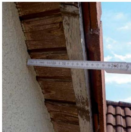
Dachüberstand kontrollieren, dieser schwindet entsprechend der Dämmstärke.
