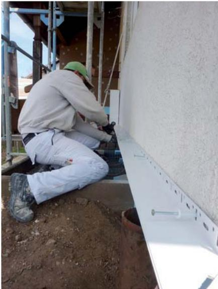
Zunächst wird das **UdiBASE®** Wandanschlussprofil der Wand folgend fluchtgerecht montiert.
