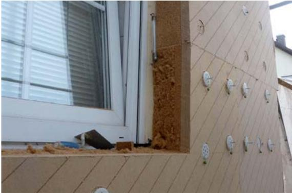
Hier ist ein exakt vorgefrästes Dübelbild zu erkennen, es sind 8 Stelldübel je Quadratmeter bzw. je Dämmelement zu setzen.
