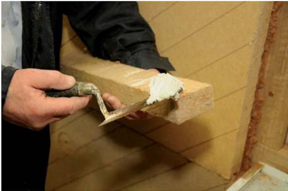
Das **UdiUNGER-DIFFUTHERM**® L Laibungsdämmelement wird mit dem lösemittelfreien **UdiSPEZIALKLEBER**® auf das **UdiRECO**® Dämmelement verklebt.
