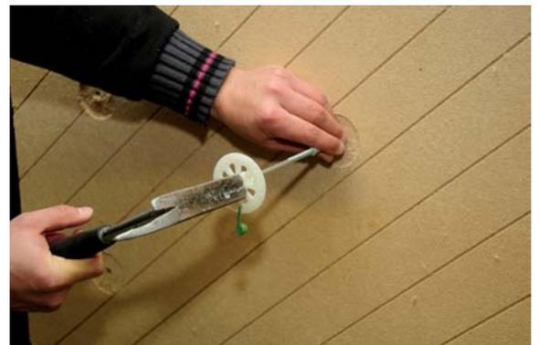
Den Dübel grundsätzlich mit etwas Geschick und behutsamen Hammerschlägen in das Bohrloch setzen, bis auf einen Abstand des Dübelkopfes von mind. 30 mm.
