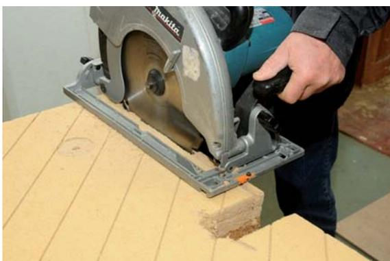
Freilegen /Abschneiden von etwa 1-2 cm der Putzträgerene zum Ausgleich / Anschmiegen an den Fußboden, Dachkasten, Balken oder andere angrenzende Bauteile.
