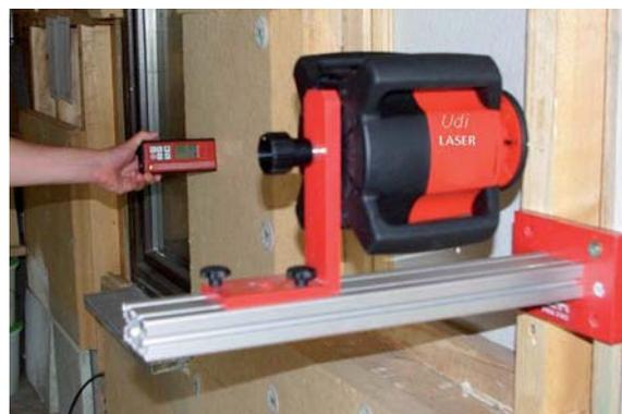
Sind alle Dübel richtig gesetzt, können diese der Reihe nach genau einjustiert werden. Dazu empfehlen wir einen Rotationslaser zu verwenden oder alternativ mit einer entsprechend langen Wasserwaage zu arbeiten. Es kann immer nur Wand für Wand gearbeitet werden, d.h. ist eine Wand korrekt ausgerichtet, wird die nächst angrenzende komplett montiert.
