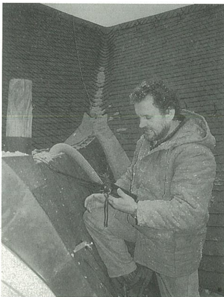
isofloc-Zellulosedämmstoff wird vom Dach aus eingeblasen
