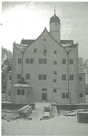
Wasserschloß Klaffenbach: Auf-Dach-Dämmung
