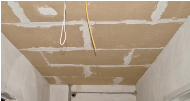
UdiDÄMMUNG montieren
