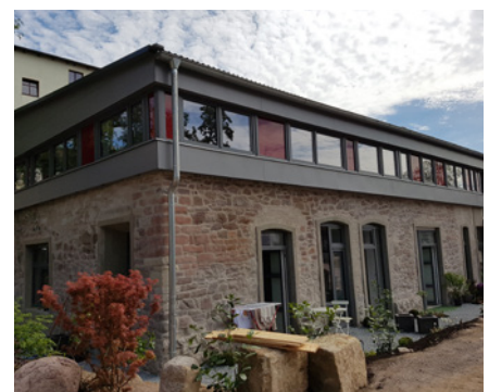
Außenansicht nach Fertigstellung
