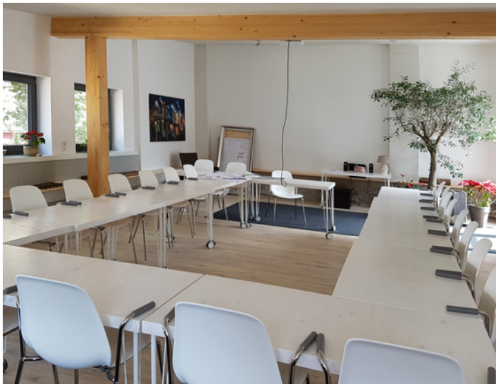
Tagungsraum mit Deckenheizung
