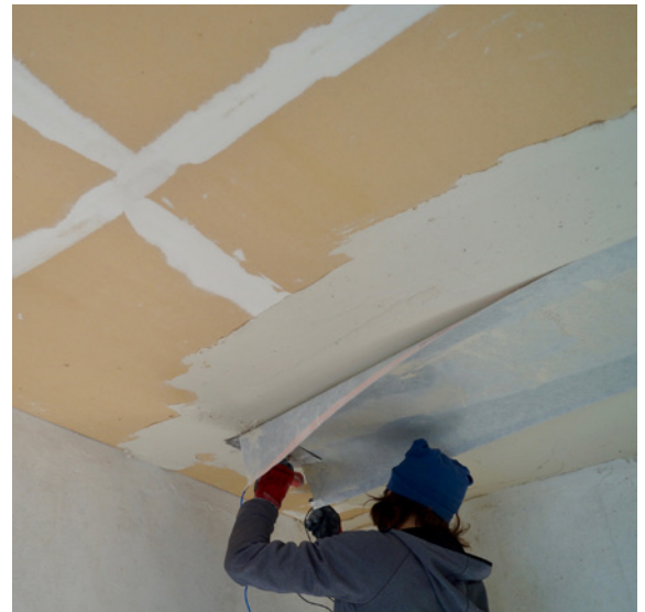
UdiSUN® beim Einspachteln
