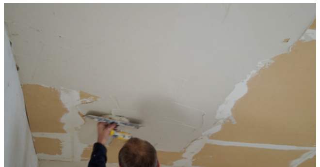
Vorspachteln mit UdiGRUNDSPACHTEL
