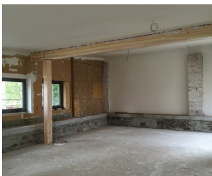
UdiSUN® im Deckenbereich verspachtelt
