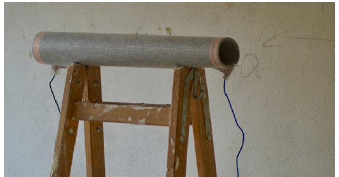
Vorbereitung der Heizbahnen
