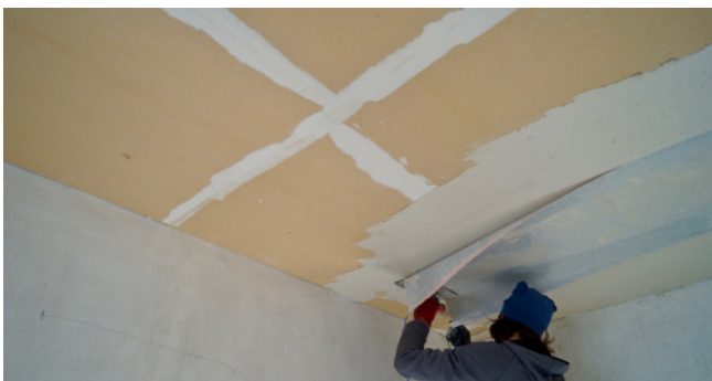
Einspachteln der Heizbahnen
