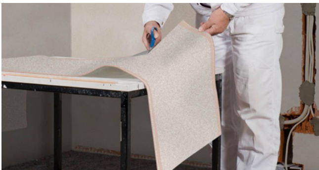
Zuschnitt der Heizbahnen (falls notwendig)
