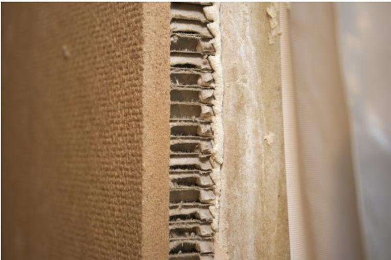
Die Gesamtstärke beträgt 23 mm, inklusive der Klebeschicht, der Luftkammerplatte und der **UdiHOLZFASER**.
