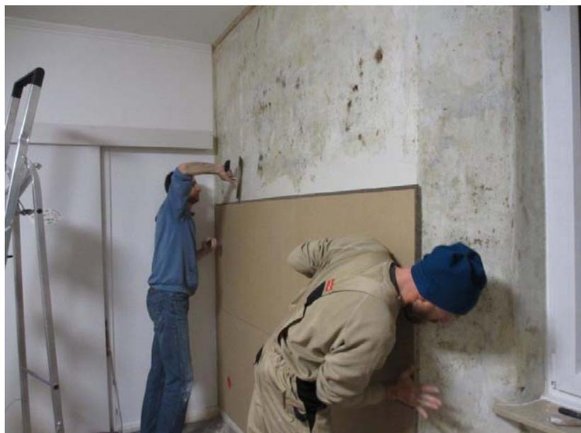
Risse werden überbrückt und leichte Unebenheiten über das Klebebett ausgeglichen.
