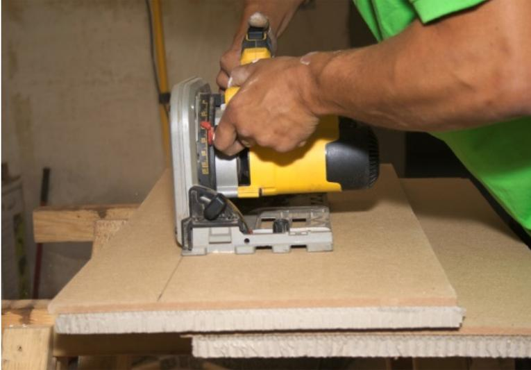
Der Zuschnitt erfolgt mit der Handkreissäge oder einem Cuttermesser.
