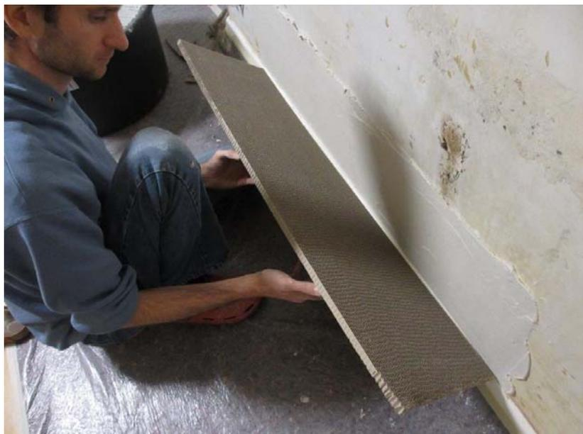
Die Dämmplatte wird ganz leicht in das vorher aufgekämmte Klebebett aus **UdiGRUNDSPACHTEL** gedrückt.
