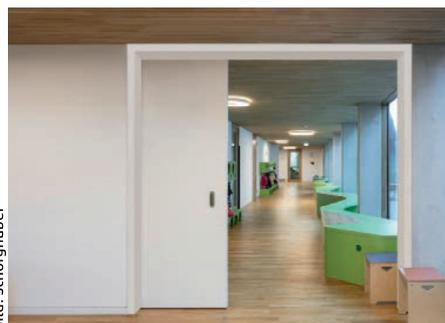
Die Schiebetür von Schörghuber mit einer Schallschutzfunktion bis zu 42 dB kann für große Flure und Durchgänge in XXL-Abmessungen ausgeführt werden.
