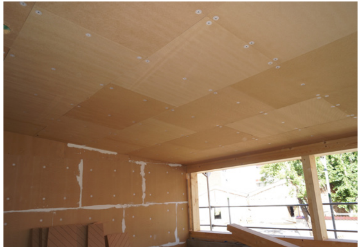
Wand- und Deckenmontage mit UdiCLIMATE ®
